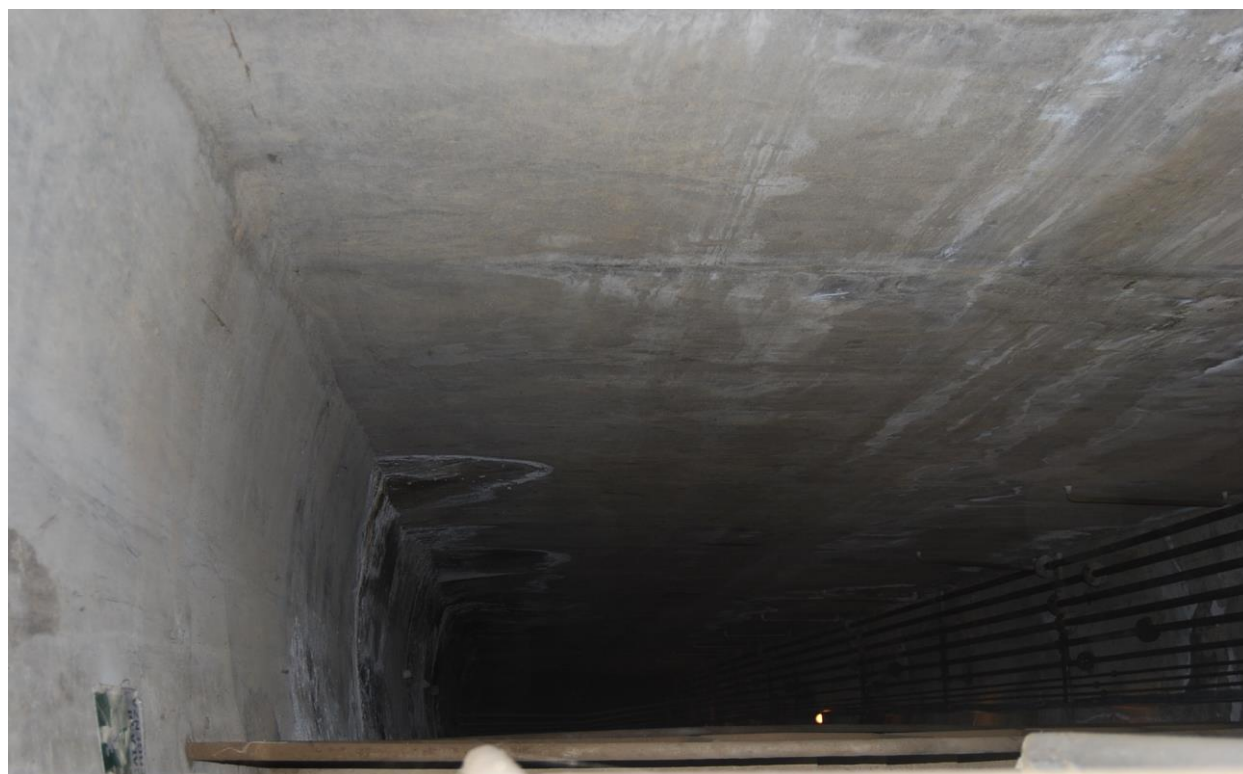
Foto 18 - Pareti del pozzo di accesso alle camere di manovra - vista dall'alto
