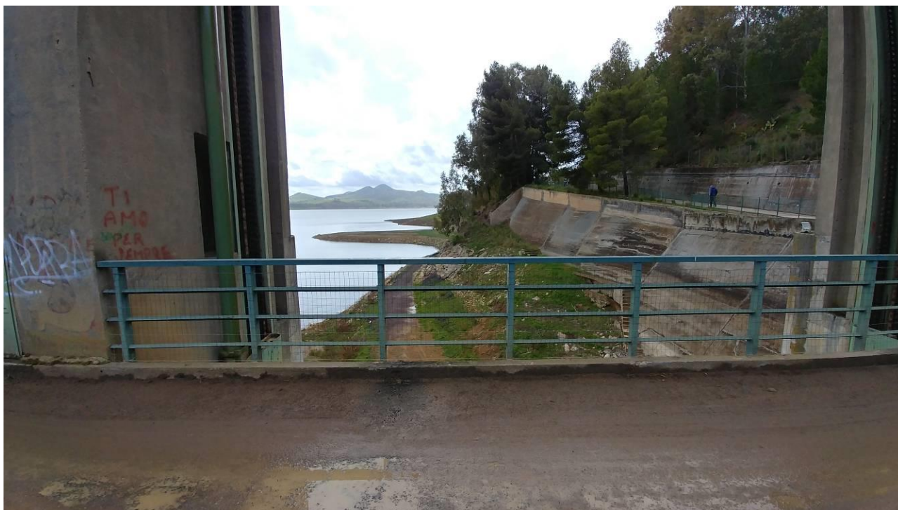
Foto 12 - Vista della sponda sinistra di monte dal coronamento in corrispondenze dello sfioratore
