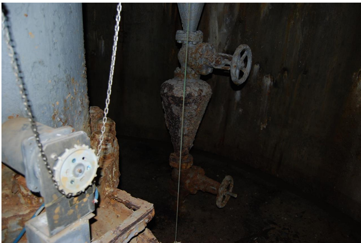
Foto 27- Camera di manovra delle paratoie dello scarico di fondo - organi di movimentazione
