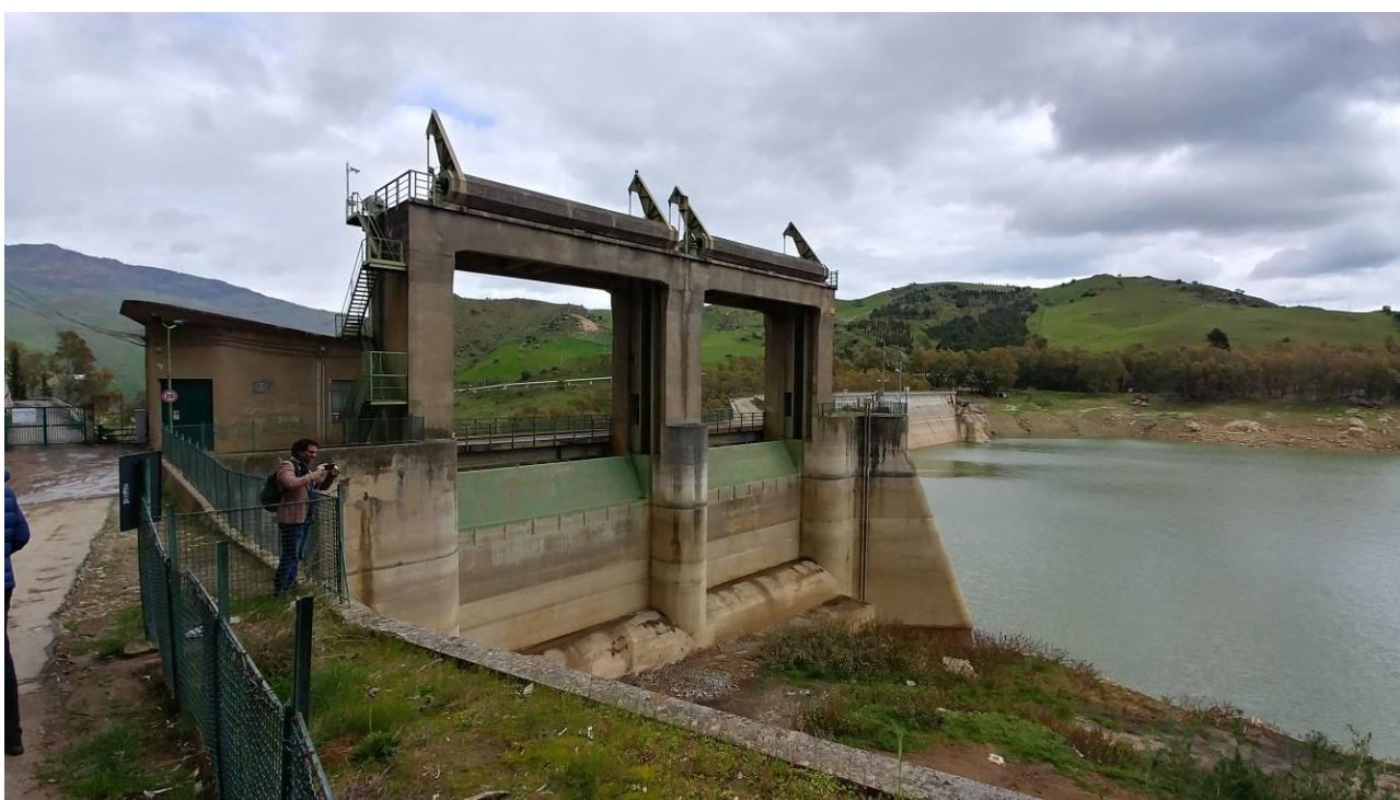
Foto 5 - Vista lato monte dello sfioratore di superficie
