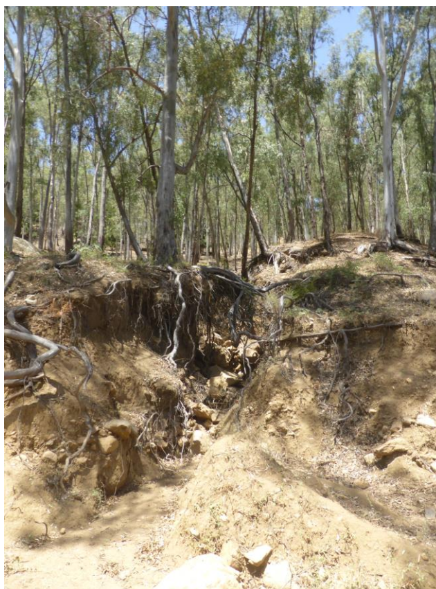
Foto 41 - Versante in sponda sinistra, area soggetta a dissesto
