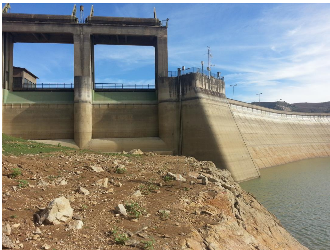
Foto 7 - Pianoro antistante lo sfioratore di superficie e vista lato monte del corpo diga
