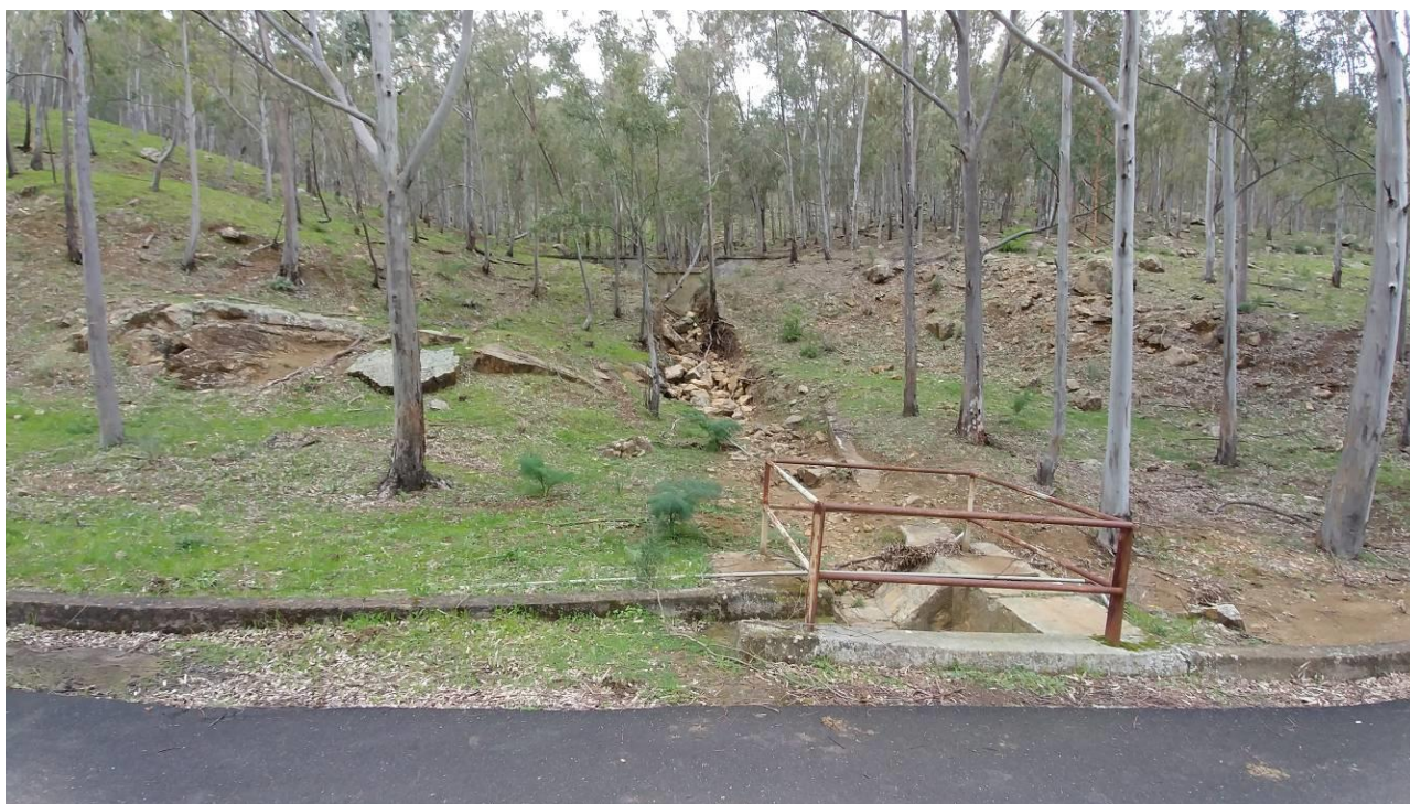
Foto 38 - Versante in sponda sinistra, vista dalla strada verso monte, particolare del fosso
