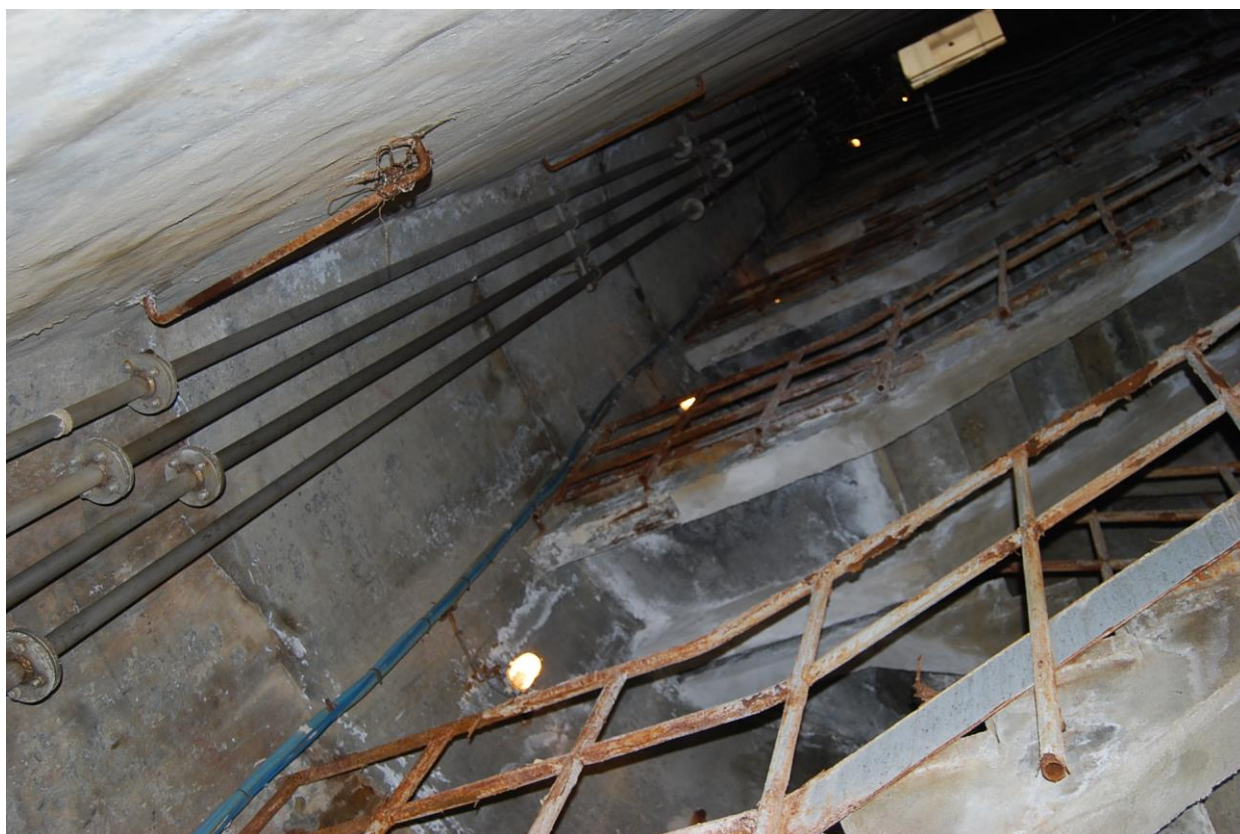
Foto 19 - Pozzo di accesso alle camere di manovra - vista dal basso
