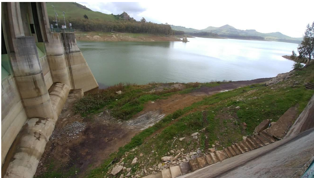
Foto 8- Pianoro antistante lo sfioratore di superficie ove sarà realizzato il pozzo di accesso alla galleria - vista dall'alto
