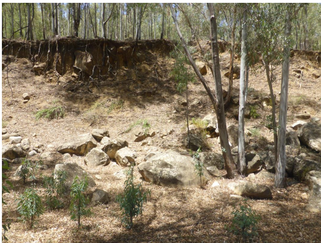
Foto 40 - Versante in sponda sinistra, area soggetta a dissesto
