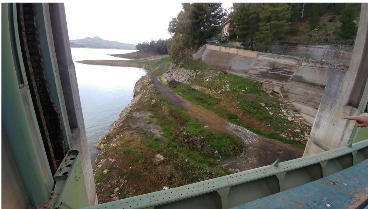
Foto 11 - Vista del pianoro dal coronamento in corrispondenze dello sfioratore
