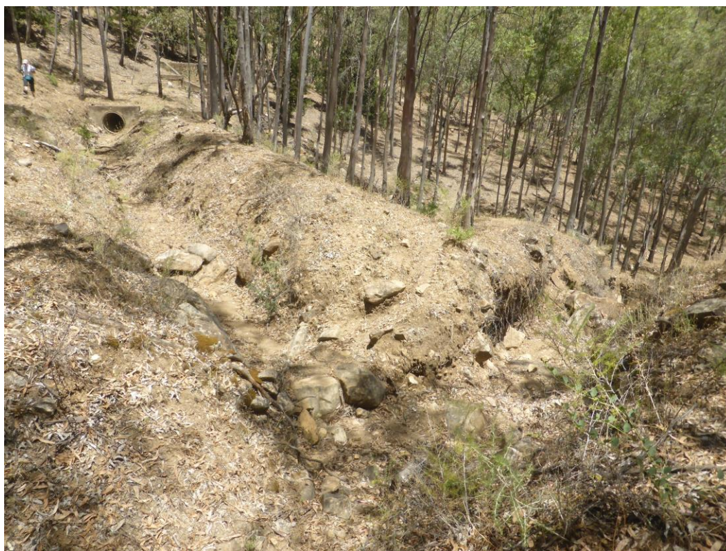
Foto 39 - Versante in sponda sinistra, area soggetta a dissesto
