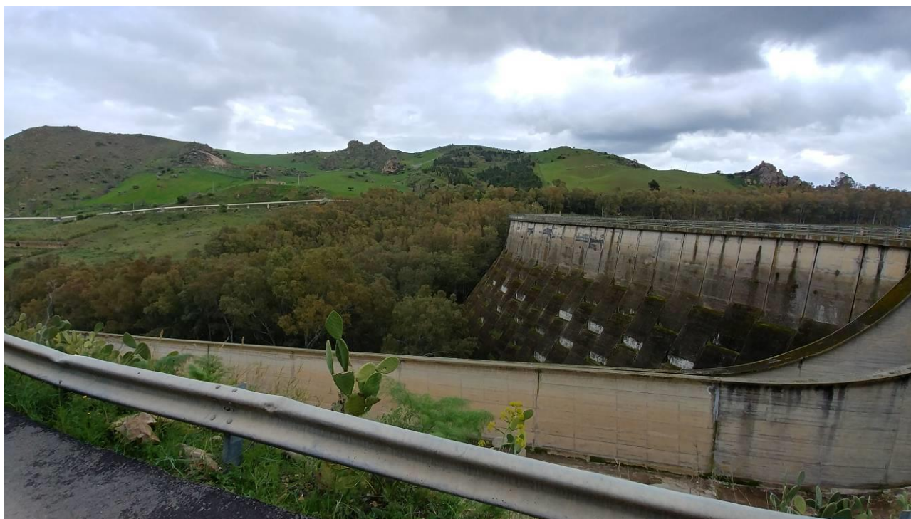
Foto 33 - Vista panoramica lato valle del corpo diga
