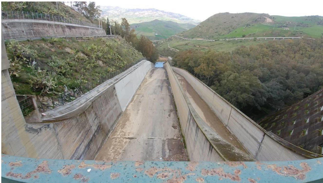
Foto 31 - Vista verso valle del canale dello sfioratore
