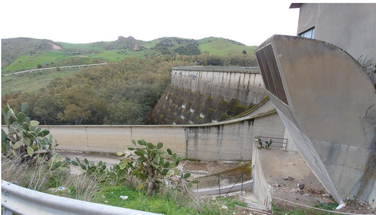
Foto 14 - Dettaglio struttura di accesso al pozzo - Presa d'aria dei condotti degli aerofori delle paratoie
