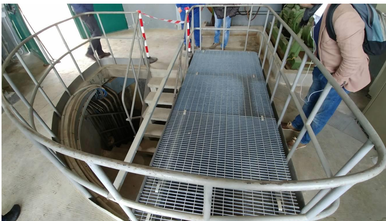
Foto 16 - Pozzo di accesso alle camere di manovra - Griglia di protezione area passaggio paratoie
