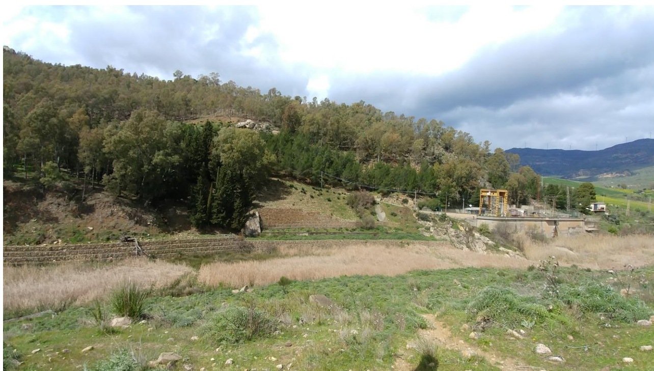
Foto 46 - Versante in sponda sinistra, vista opera di sostegno in gabbionata e impianto idroelettrico
