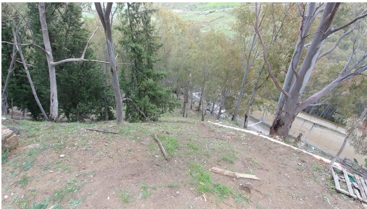
Foto 36 - Versante in sponda sinistra, vista da monte verso la vasca di dissipazione
