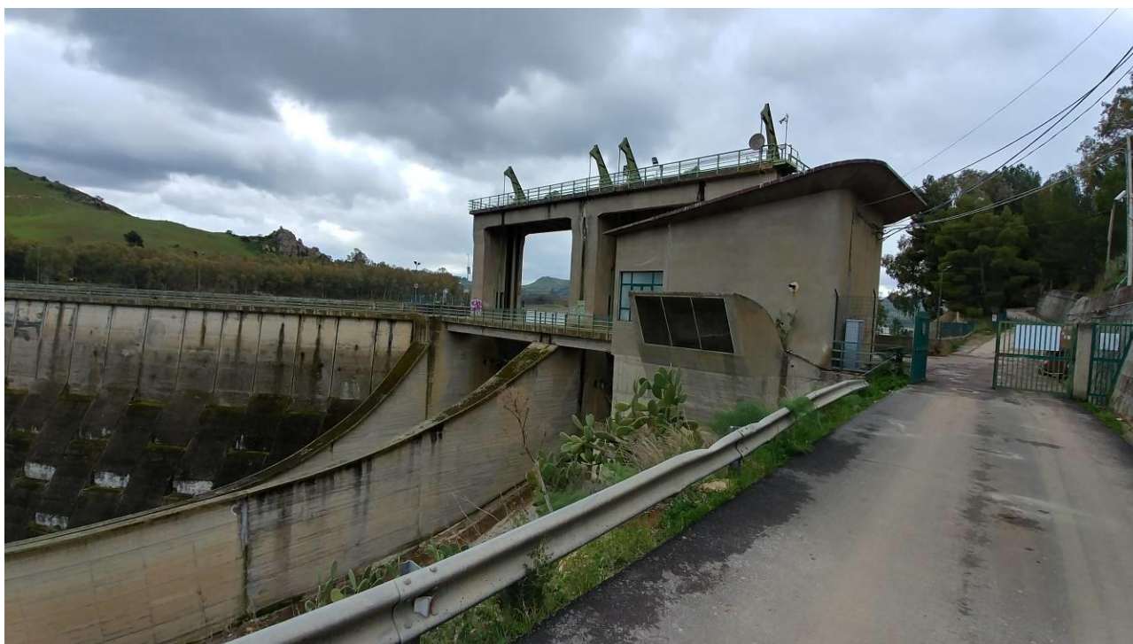
Foto 13 - Struttura di accesso al pozzo - Lato valle
