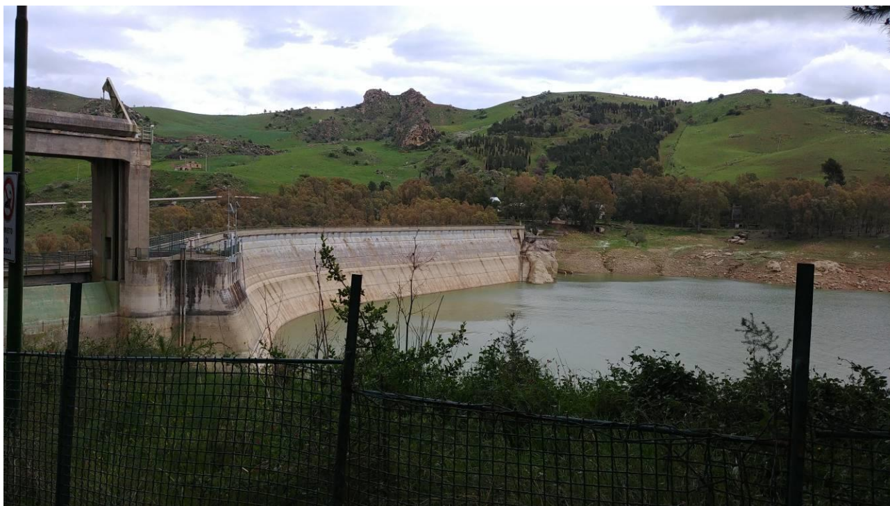
Foto 4 - Vista lato monte del corpo diga
