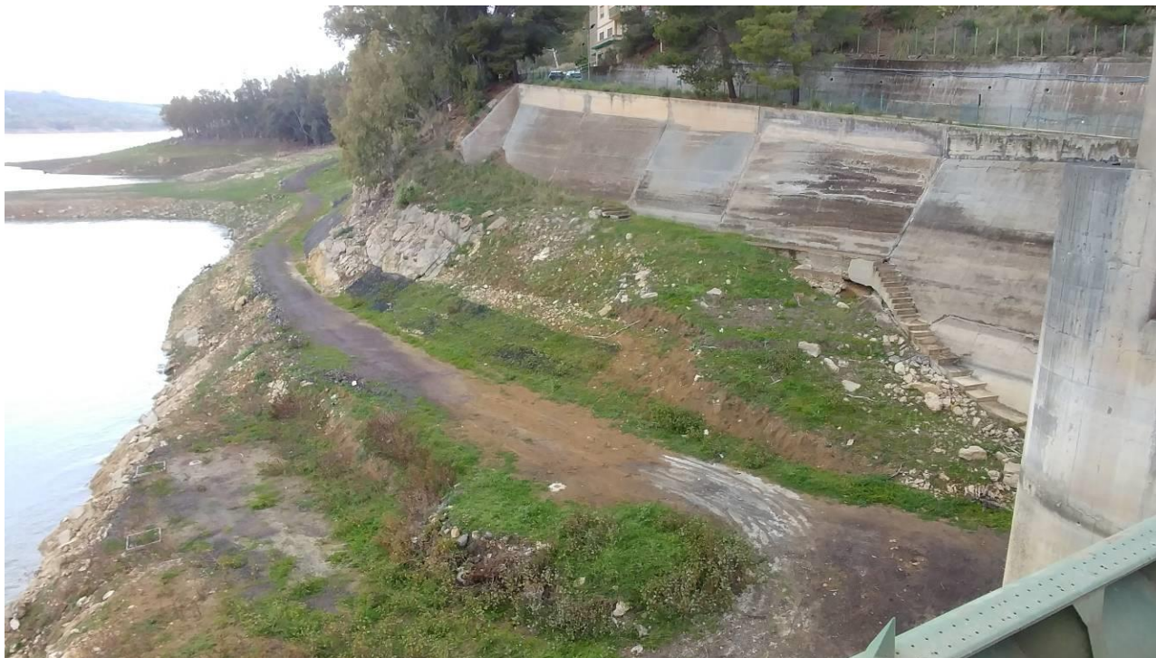
Foto 10 - Pista di accesso al pianoro antistante lo sfioratore di superficie
