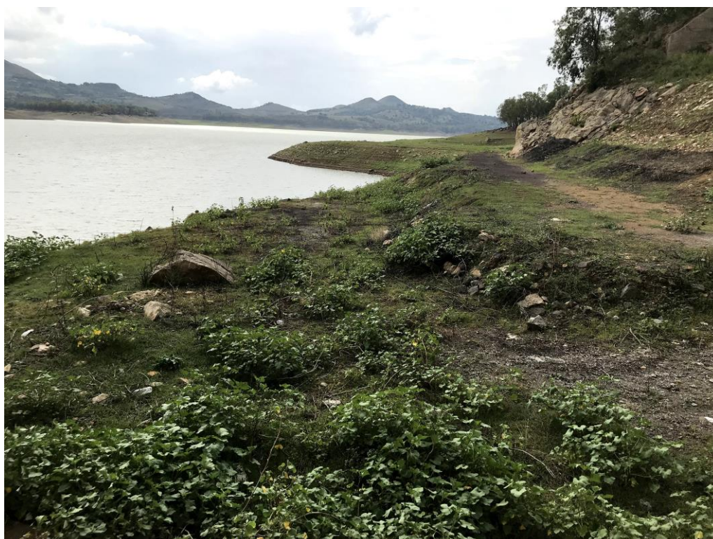
Foto 9- Pianoro antistante lo sfioratore di superficie ove sarà realizzato il pozzo di accesso alla galleria - vista dal pianoro
