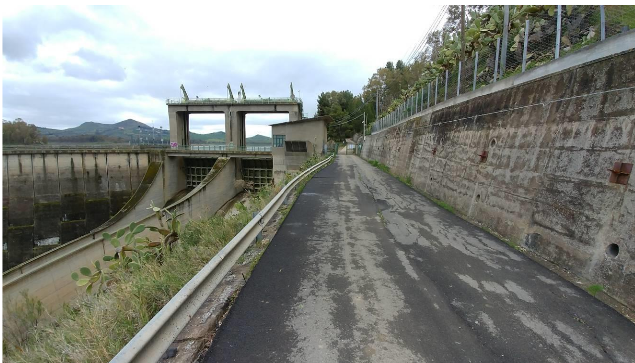
Foto 34 - Vista lato valle delle paratoie dello sfioratore di superficie
