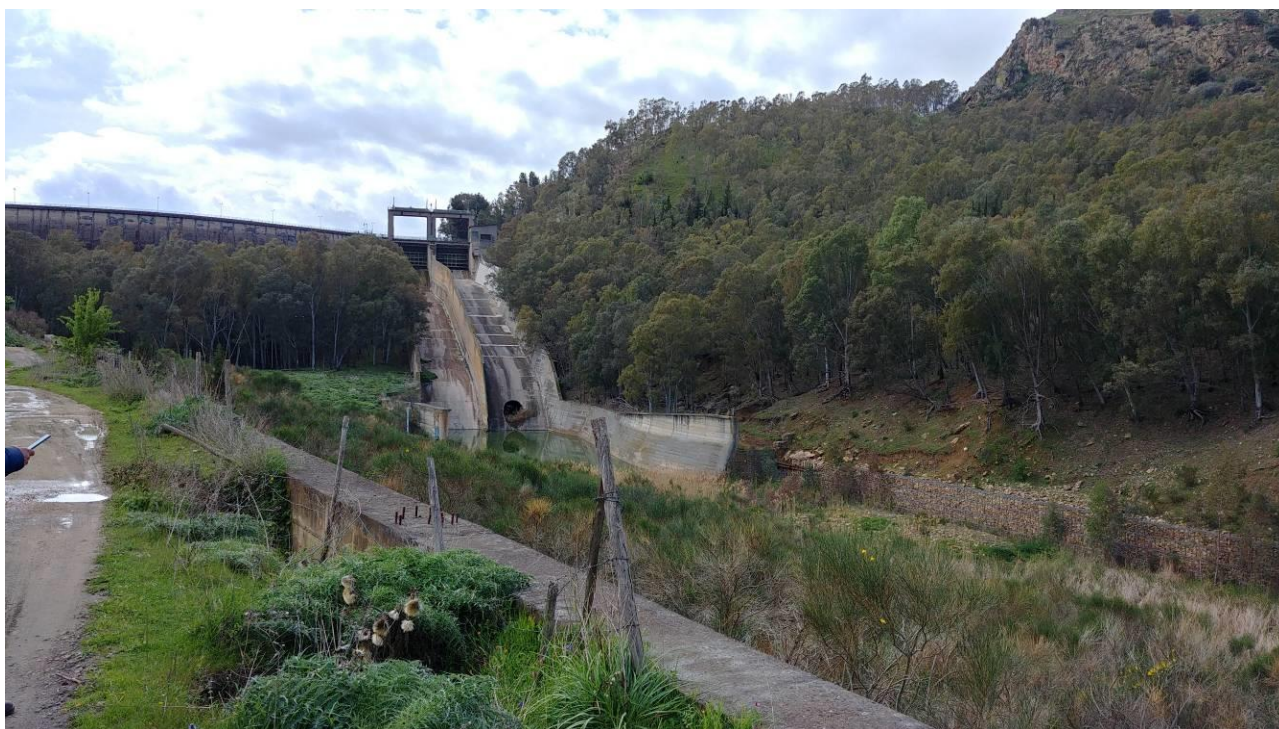
Foto 35 - Vista lato valle del canale di sfioro della vasca di dissipazione e della bocca d'uscita dello scarico di fondo
