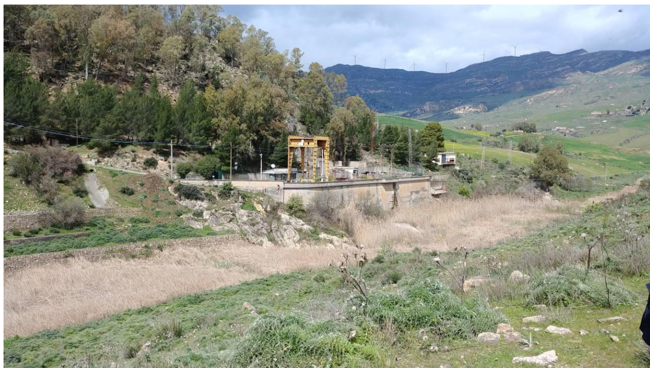
Foto 47 - Versante in sponda sinistra, dettaglio impianto Idroelettrico
