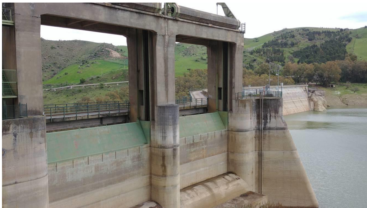
Foto 6 - Vista lato valle dello sfioratore di superficie (dettaglio)
