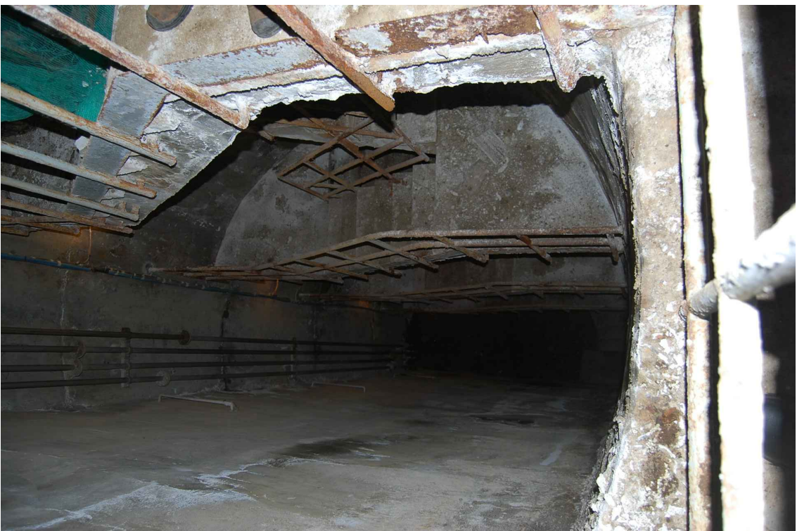
Pozzo di accesso alle camere di manovra vano per estrazione paratoie
