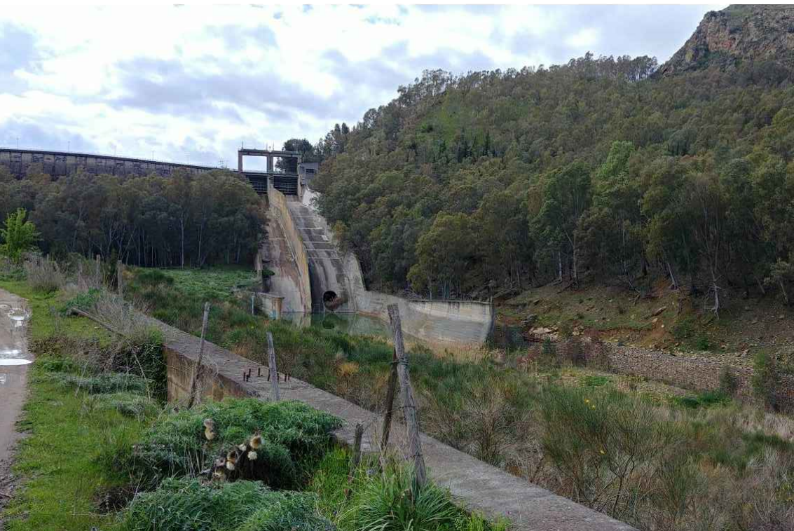
Vista lato valle del canale di sfioro della vasca di dissipazione e della bocca d'uscita dello scarico di fondo. (FOTO 35)
