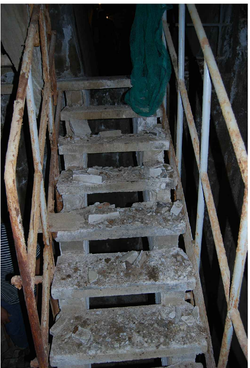
Scale del pozzo di accesso - Dettaglio degrado strutturale.
