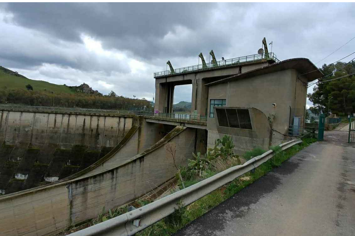
Struttura di accesso al pozzo (lato valle). (FOTO 13)
