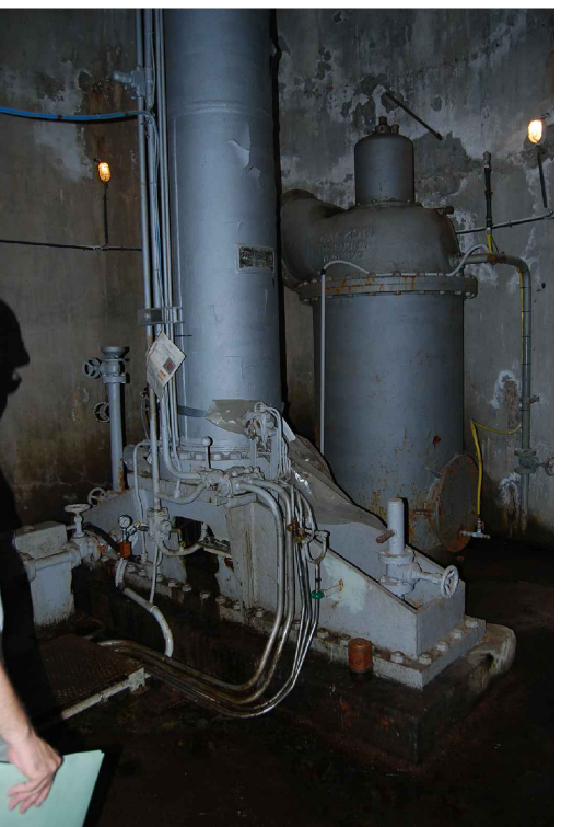
Paratoia dell'organo della galleria di derivazione. (FOTO 23)
