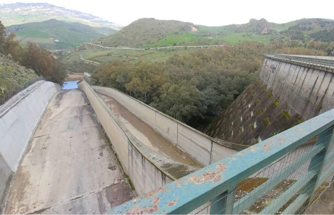
Vista lato valle del canale dello sfioratore e del corpo diga. (FOTO 32)
