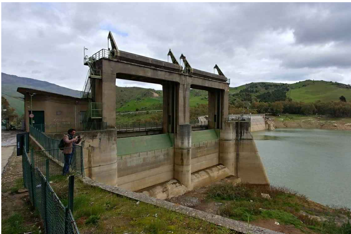
Vista lato monte dello sfioratore di superficie. (FOTO 5)
