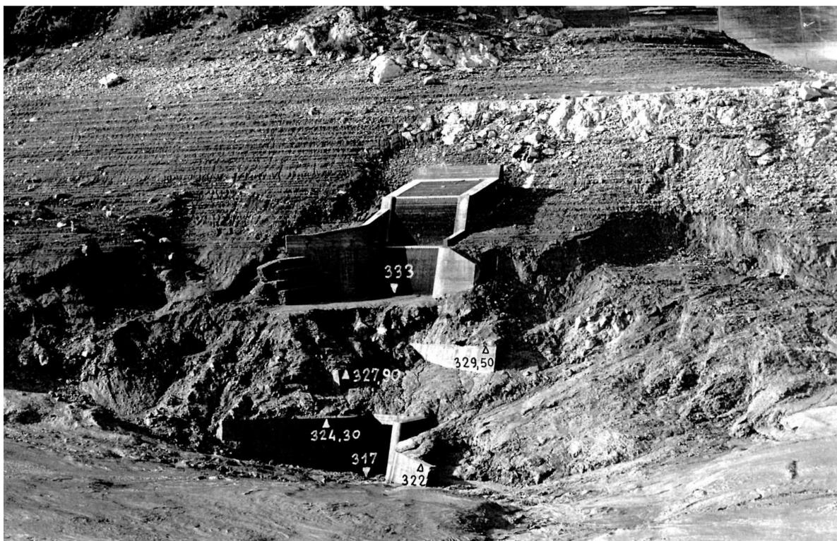
**Figura 7.7: Foto storiche dell'opera di derivazione (sopra) e dello scarico di fondo (sotto)**
