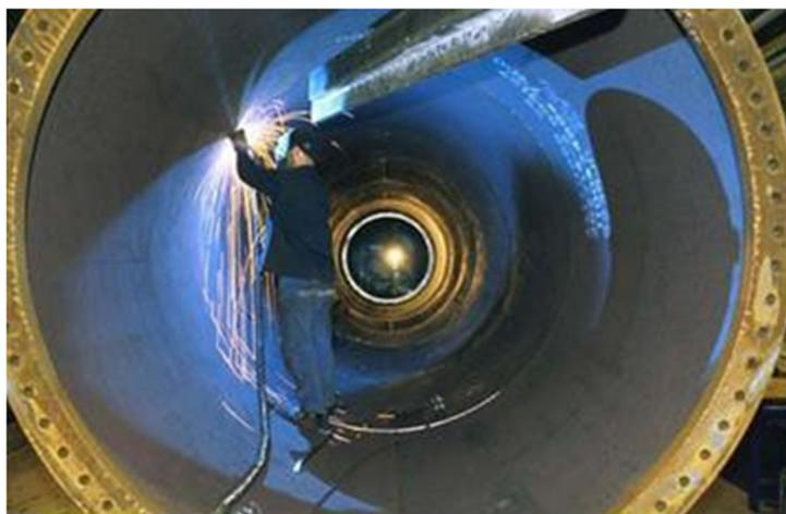
Figura 11: Interno di una torre
