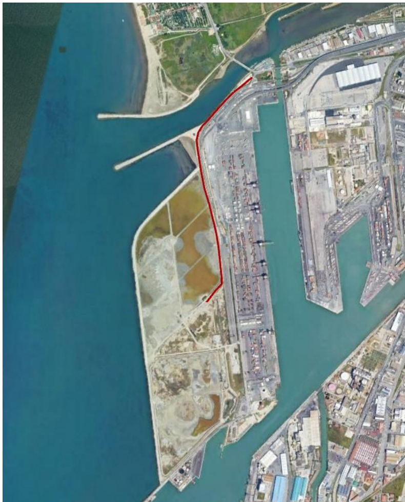
Figura 9 Percorso di accesso alla zona di cantiere
