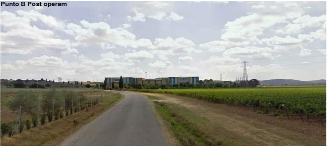
Figura 4-145 - Post operam Intervento F Punto B
