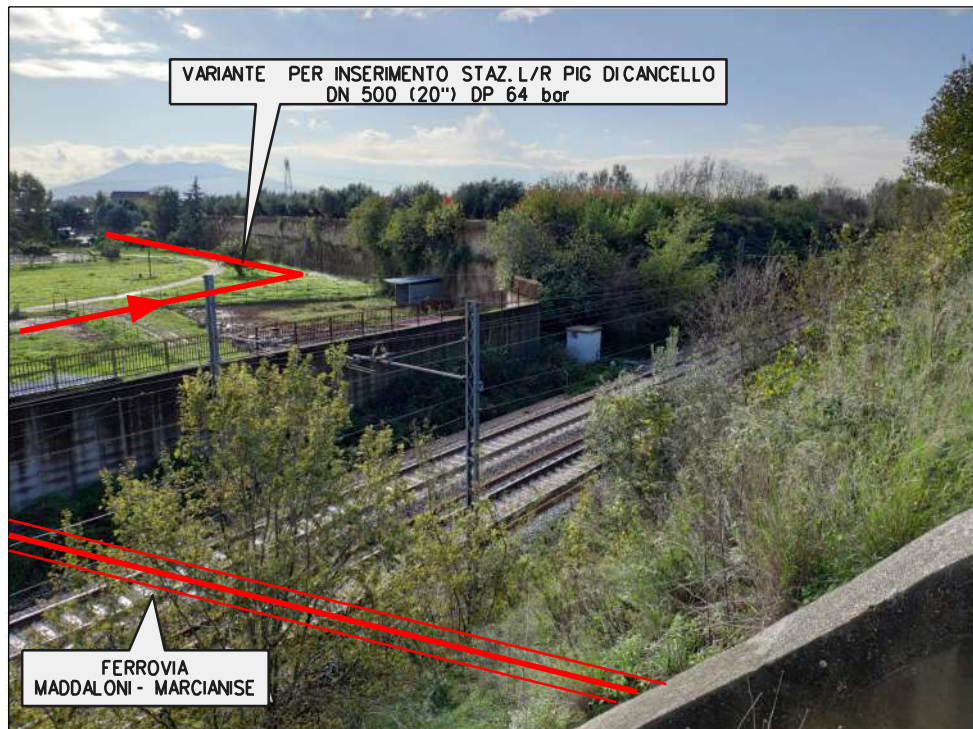
Attraversamento Ferrovia Maddaloni-Marcianise
