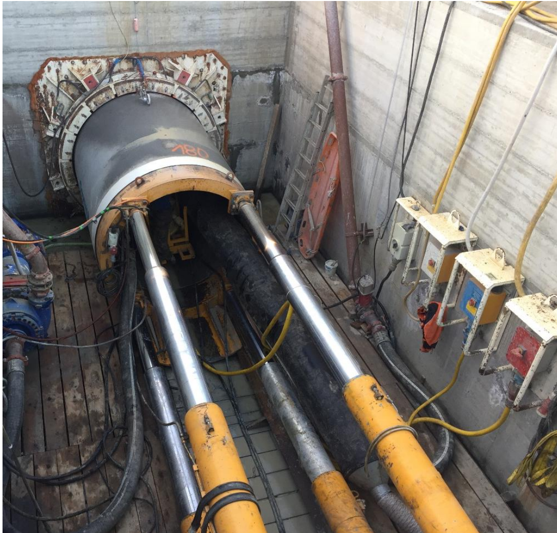
Fig. 9.4: Postazione di spinta in c.a. e stazione di spinta
