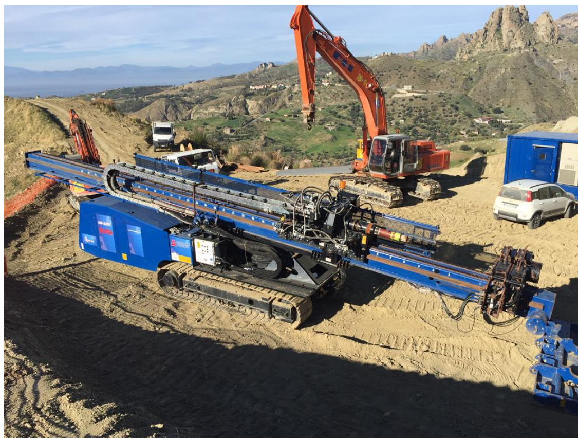
Fig. 9.2: Rig utilizzato per esecuzione di T.O.C.
