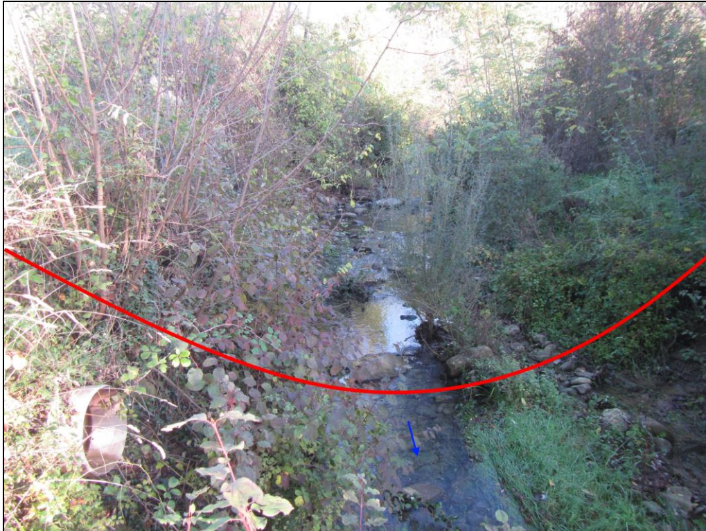
Fig.8.3/A: Foto ambito di attraversamento del corso d'acqua (torrente Bregine)
