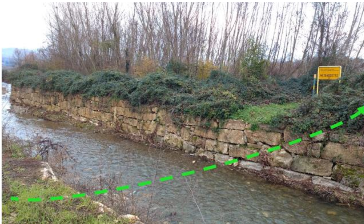
Figura 5.3.2.2/M: Dense formazioni a Rubus ulmifolius lungo le sponde di massi del Torrente Chiassa, attraversato, nel punto in questione, dal metanodotto principale in dismissione (linea verde)
