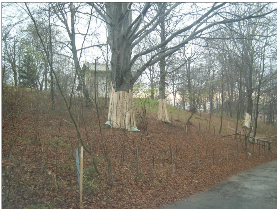
Figura 7.2/A: Tecnica di salvaguardia di alberi posti all'interno dell'area di passaggio, prima dei lavori
