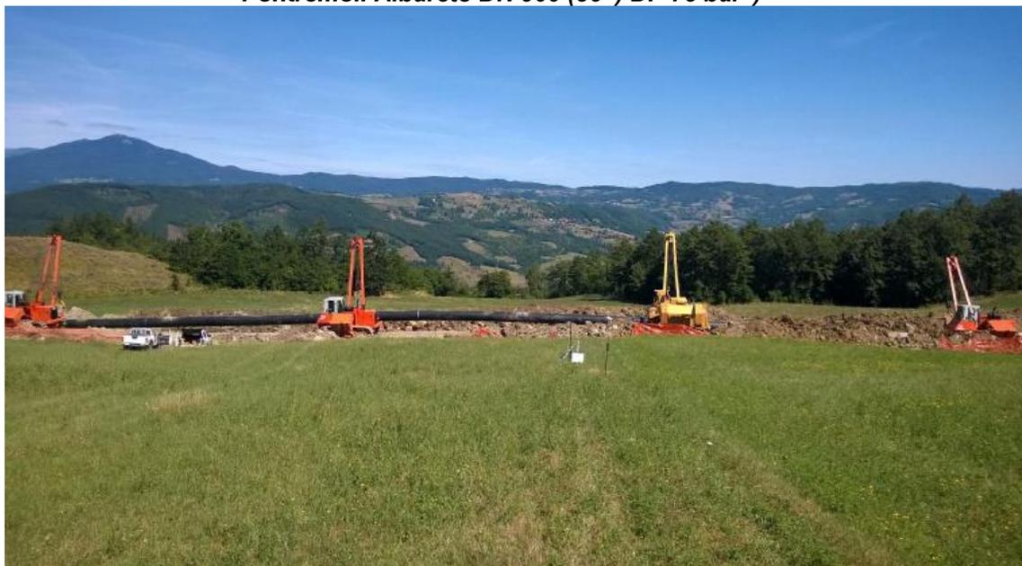
Le misure fonometriche in cantiere sono state effettuate nelle comuni condizioni di cantiere, in normali condizioni climatiche, con cielo sereno, temperatura intorno ai 24 °C, vento tra 0,3 m/s e 2 m/s e assenza di pioggia, isolando il contributo acustico di ognuna delle fasi di costruzione del metanodotto.
