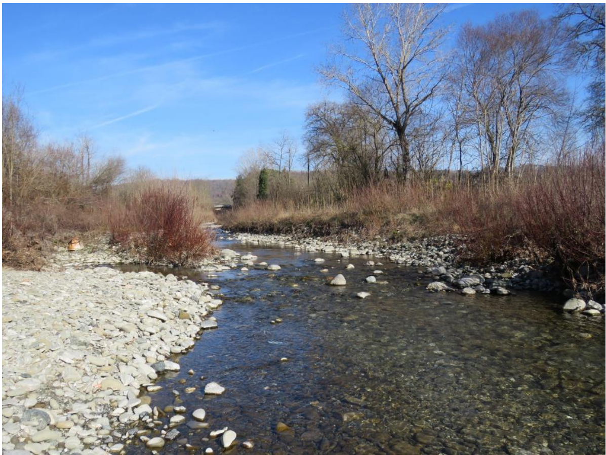
Fig. 4.2/C: Il torrente Sovara nell'area di interferenza del progetto costituisce al tempo stesso un corridoio ripariale e un corridoio ecologico fluviale da riqualificare
