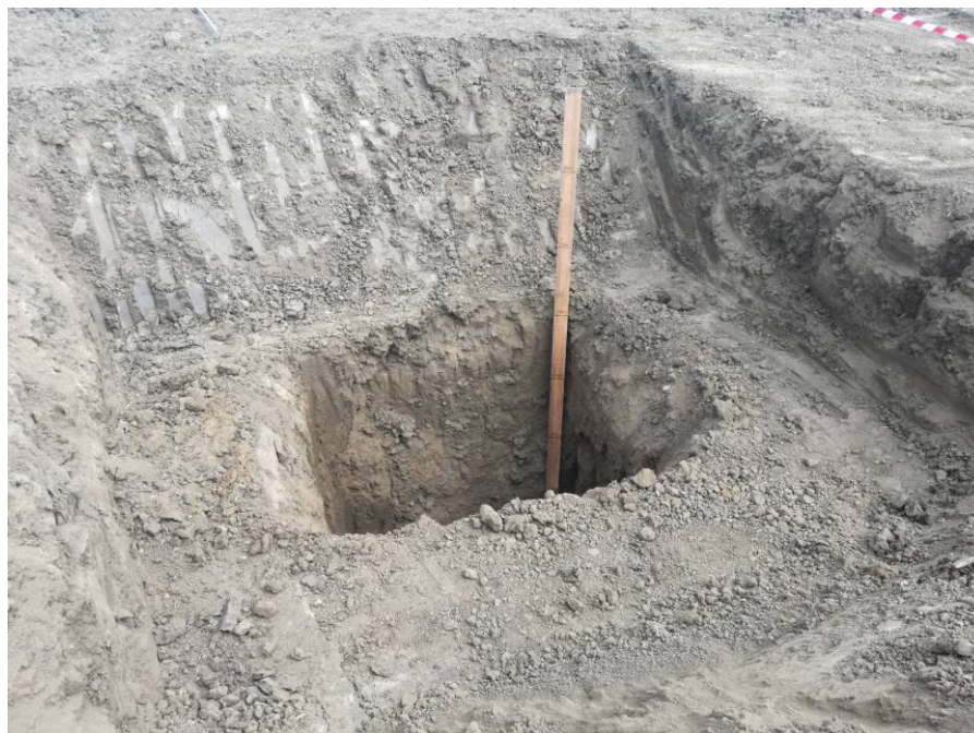
Foto 1 – Scavo pozzetto a sezione obbligata
