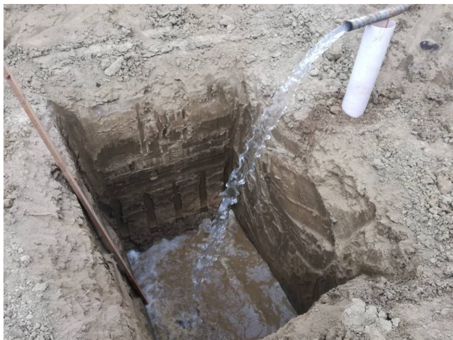
Foto 6: - Riempimento del pozzetto
