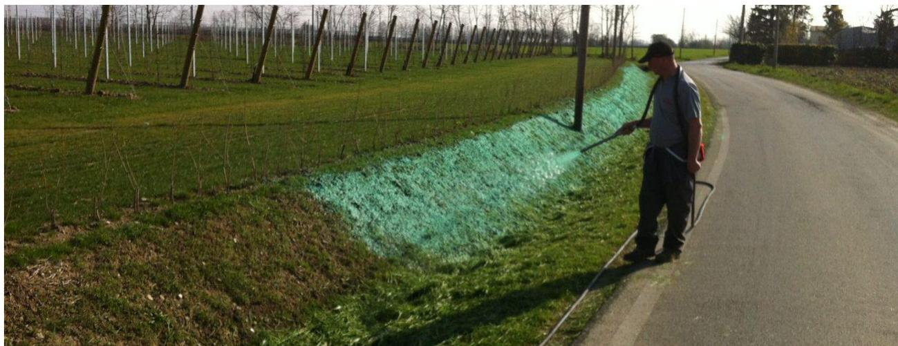
**Figura 15:** tecniche di idrosemina
