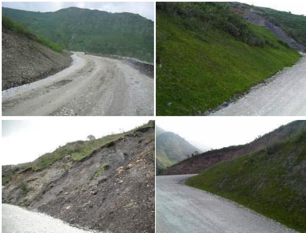
Fig. 39 Esempi di inerbimento post operam delle scarpate oggetto di intervento
