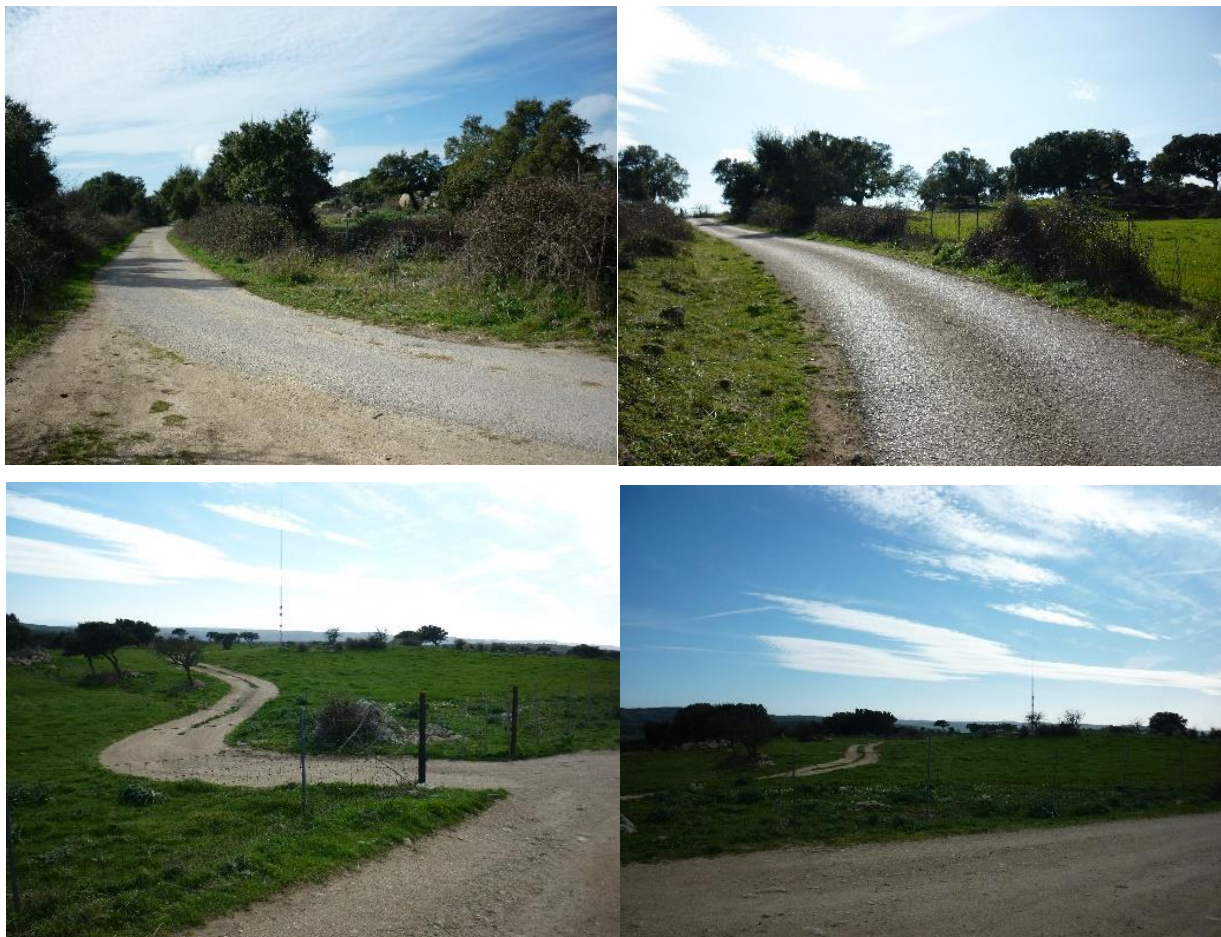
Fig. 38 documentazione fotografica dello stato attuale della viabilità interna al parco
