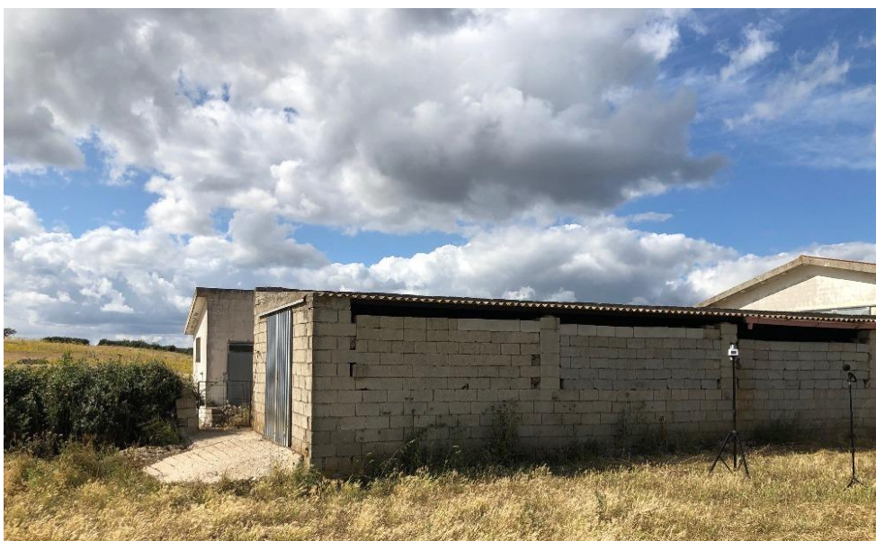
Figura 9: Dettaglio posizione microfono e centralina meteo
