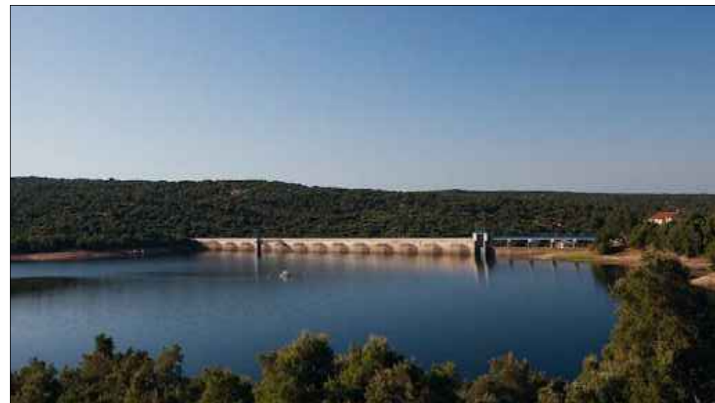
LAGO SOS CANALES. Il primo intervento umano sul Tirso fu la realizzazione di un invaso artificiale (il primo in Sardegna) con lo sbarramento della diga "Sos Canales" nei pressi di Buddusù, a pochi chilometri dalle sue sorgenti, generando così l'omonimo lago; il lago artificiale così creato aveva una capacità di 3,5 milioni di metri cubi d'acqua.
