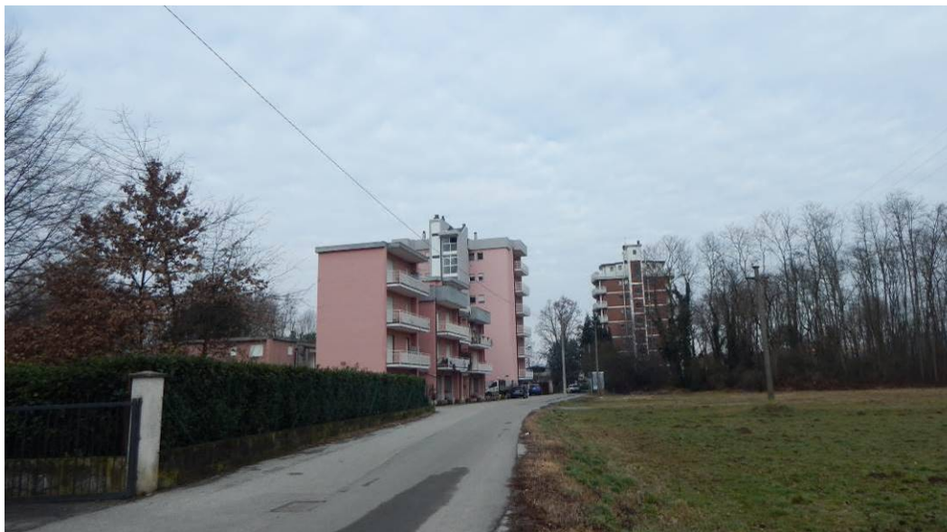
Figura 39: vista da via del Lago da sud
