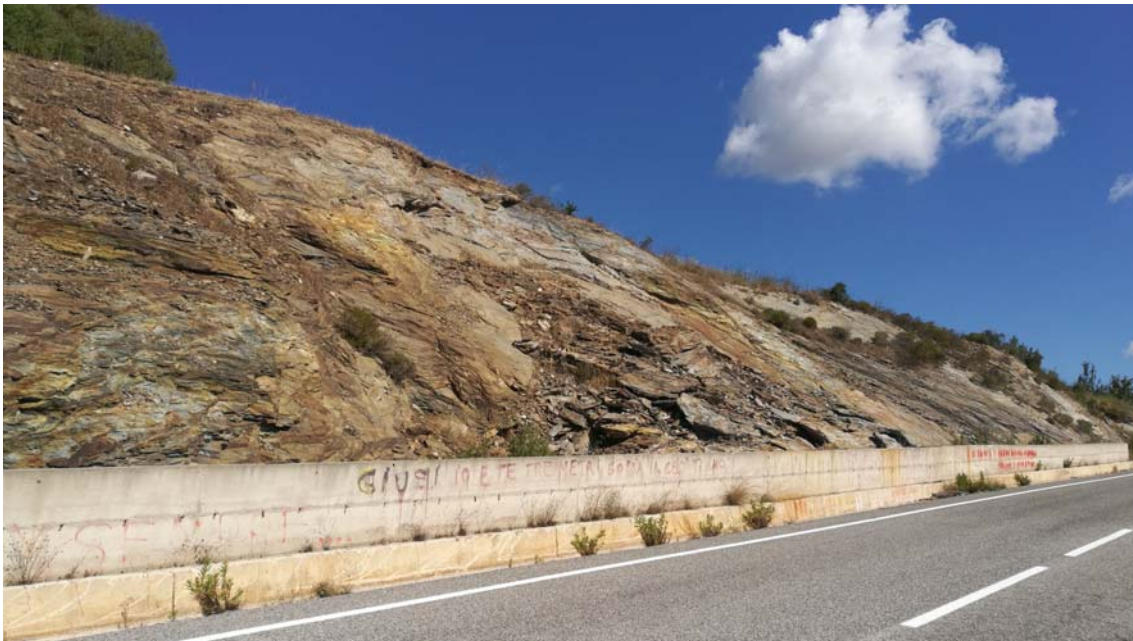
Foto – Le filladi di Lula in condizione di franappoggio
