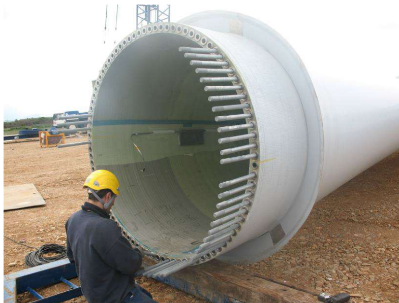
Fig. 6 : vista perni ancoraggio pala
