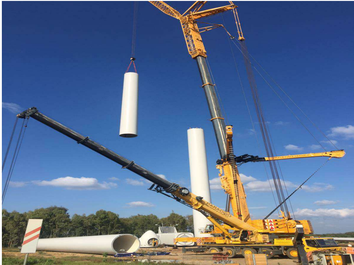
Fig. 14 : montaggio tronco di torre intermedio
