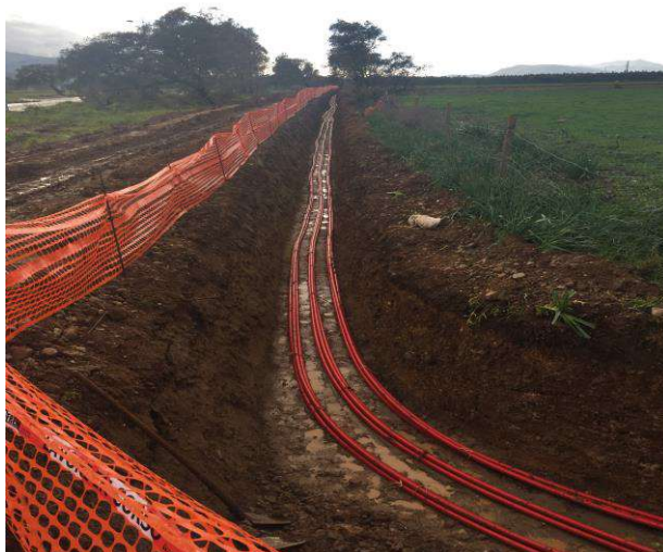
Fig. 22 : posa cavidotti MT parco del Guspinese
