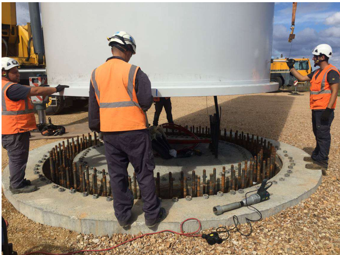
Fig. 13 : preparazione montaggio primo tronco di torre (bottom) su dado fondazione
