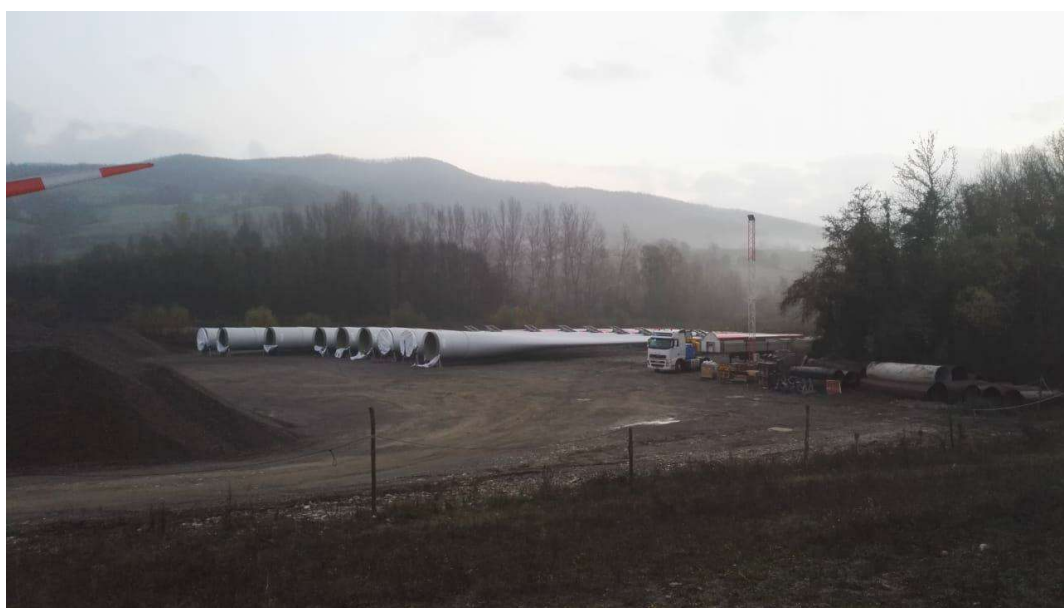
Fig. 10 : stoccaggio temporaneo pale nell'area di trasbordo
