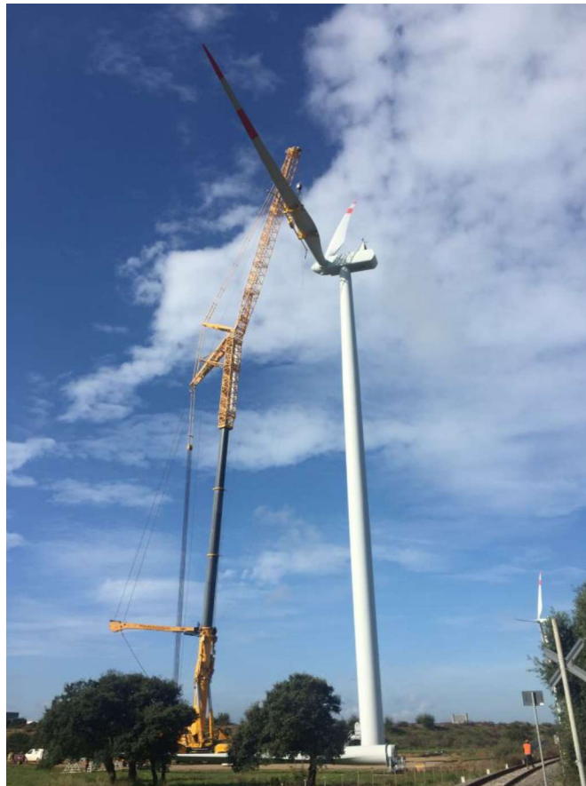
Fig. 16 : montaggio pale
