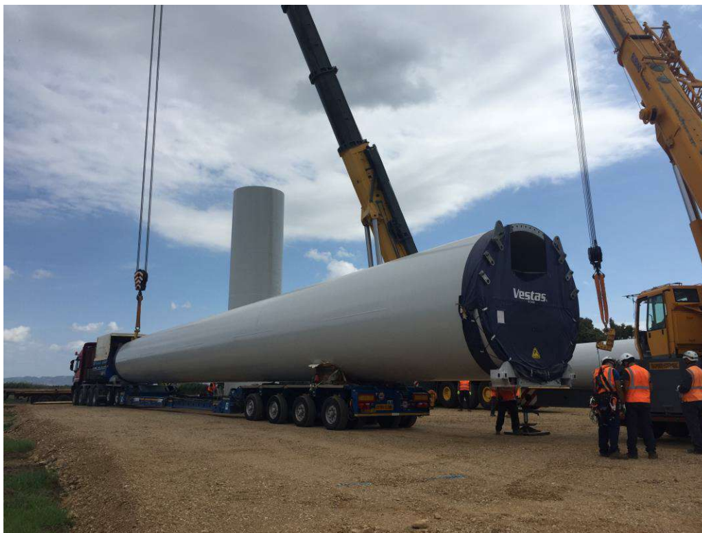
Fig. 11 : scarico di tronco di torre
