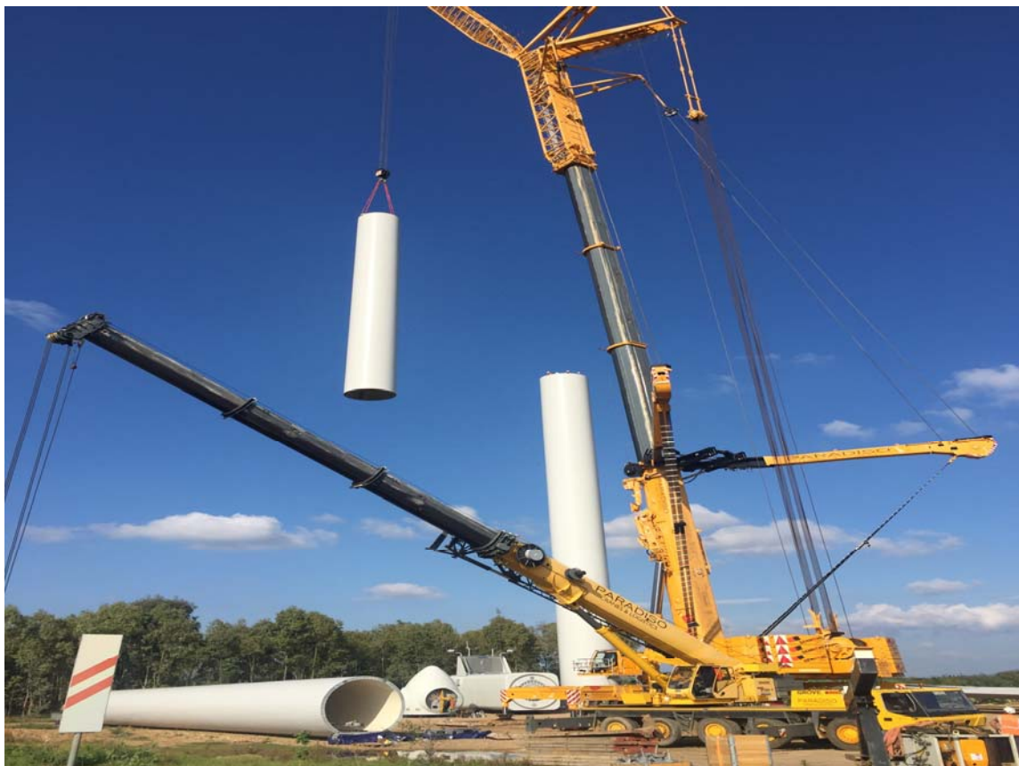
Fig. 14 : montaggio tronco di torre intermedio
