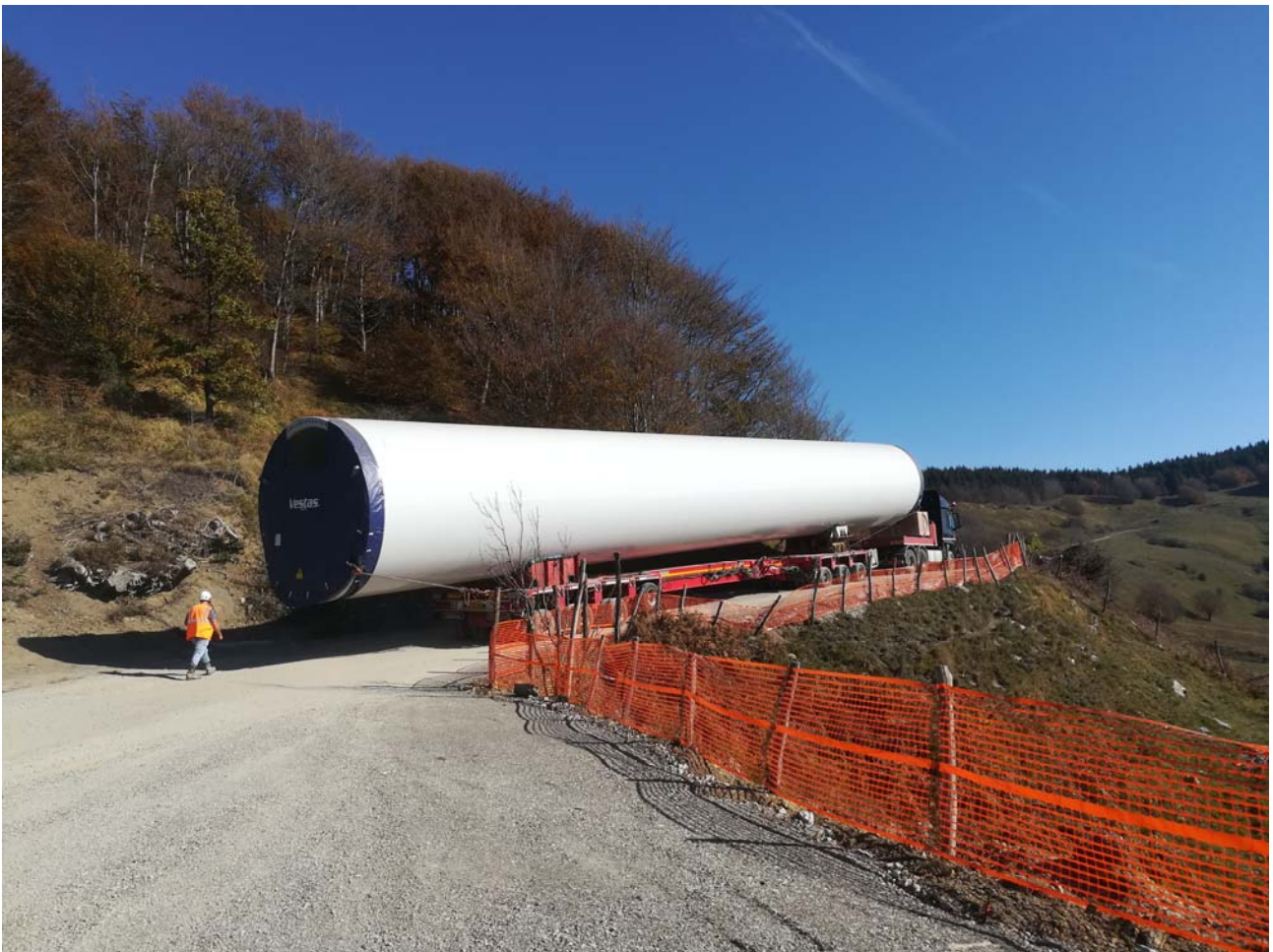
Fig. 9 : mezzo trasporto eccezionale speciale tronco di torre (semovente)
