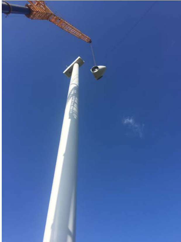
Fig. 15 : montaggio supporto rotore (hub)
