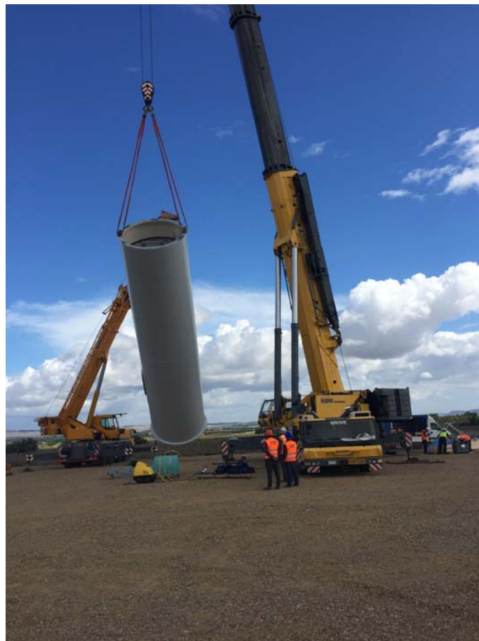
Fig. 12 : sollevamento primo tronco di torre (bottom) su dado fondazione
