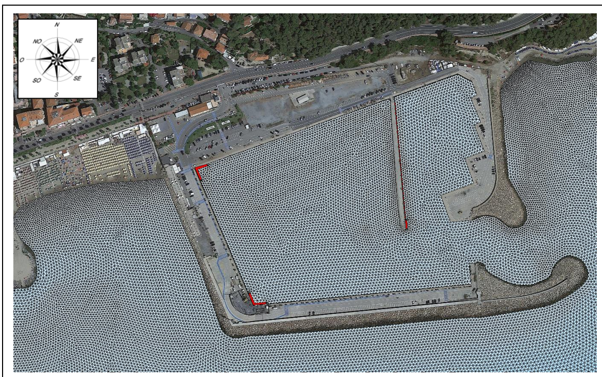
Fig. 8.1 – Particolare della mesh di calcolo in prossimità e all'interno del porto – Configurazione di progetto
