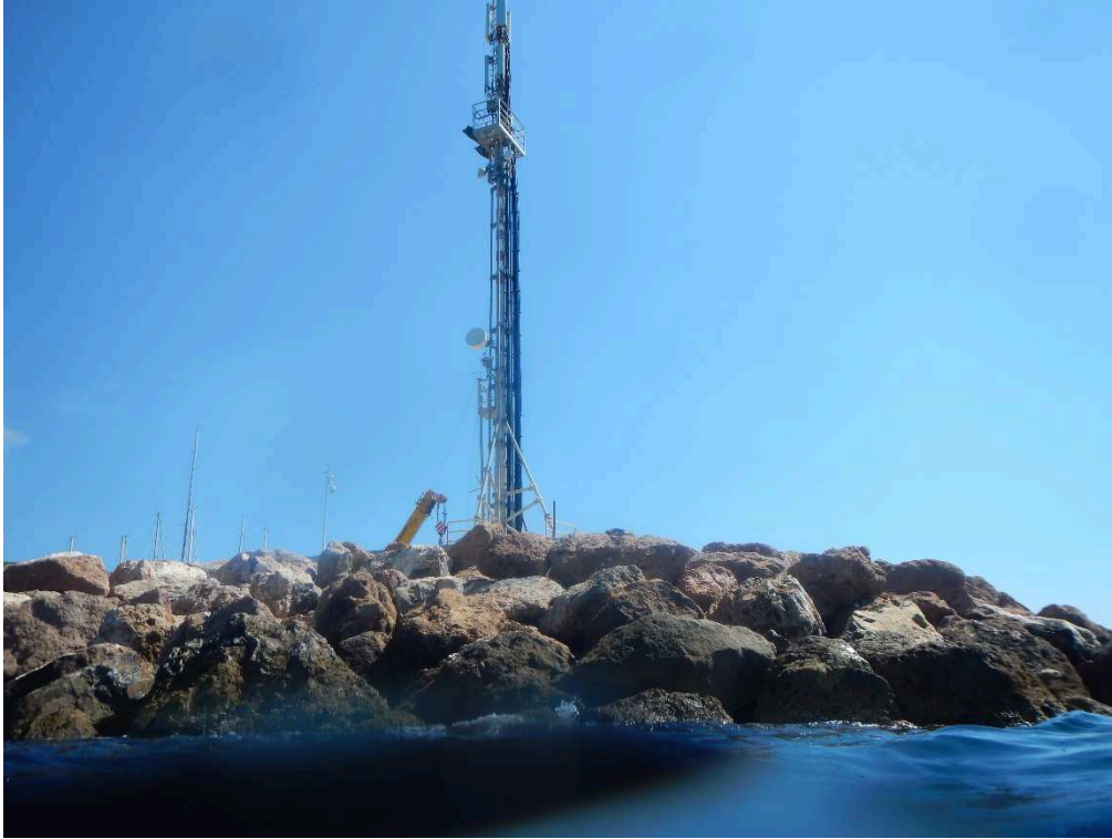
Foto ripresa in corrispondenza della SEZIONE 11
