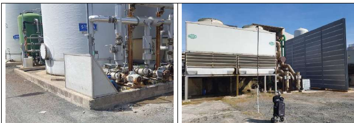
Foto 19-20: a sin. schermo per pompa/motore, a destra una barriera davanti a torre evaporativa
