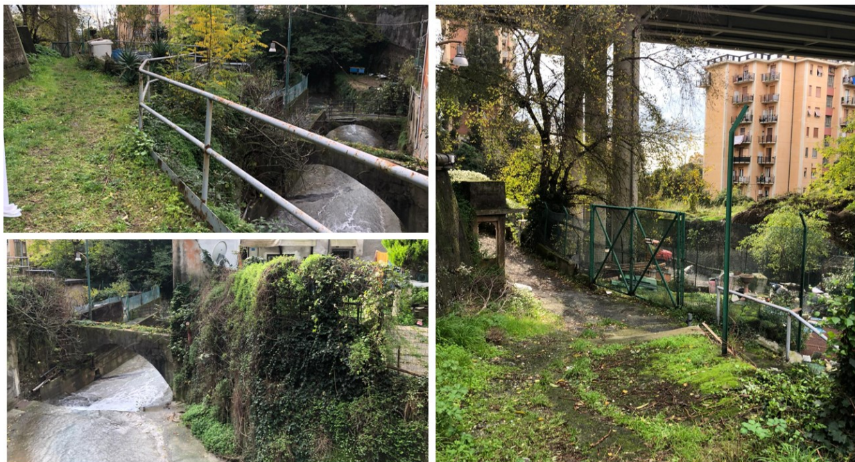
Figura 4-2: foto area di progetto in prossimità dell'attraversamento autostradale
