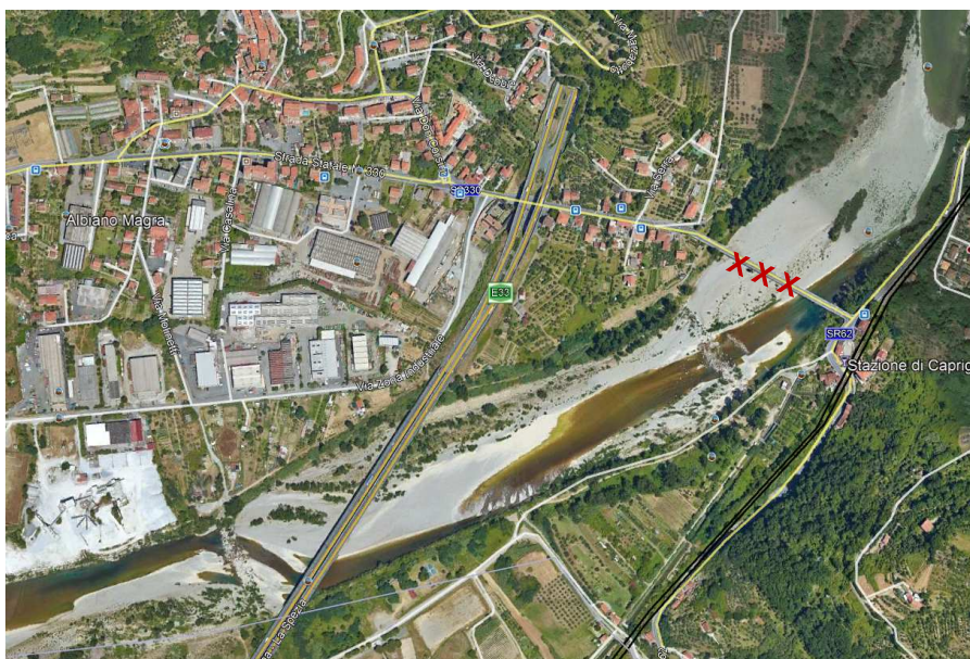
Inquadramento dell'area d'interesse (la tripla X rossa evidenzia il ponte crollato).
