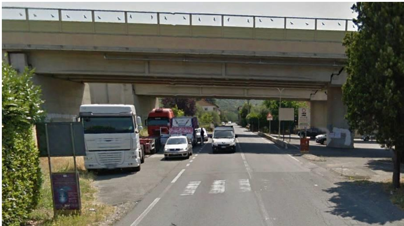
Figura 13: Foto sotto l'Autostrada A15
