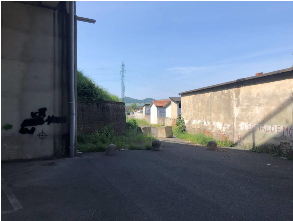
Figura 11: Foto lato Ovest della A15, in prossimità dell'area cimiteriale
