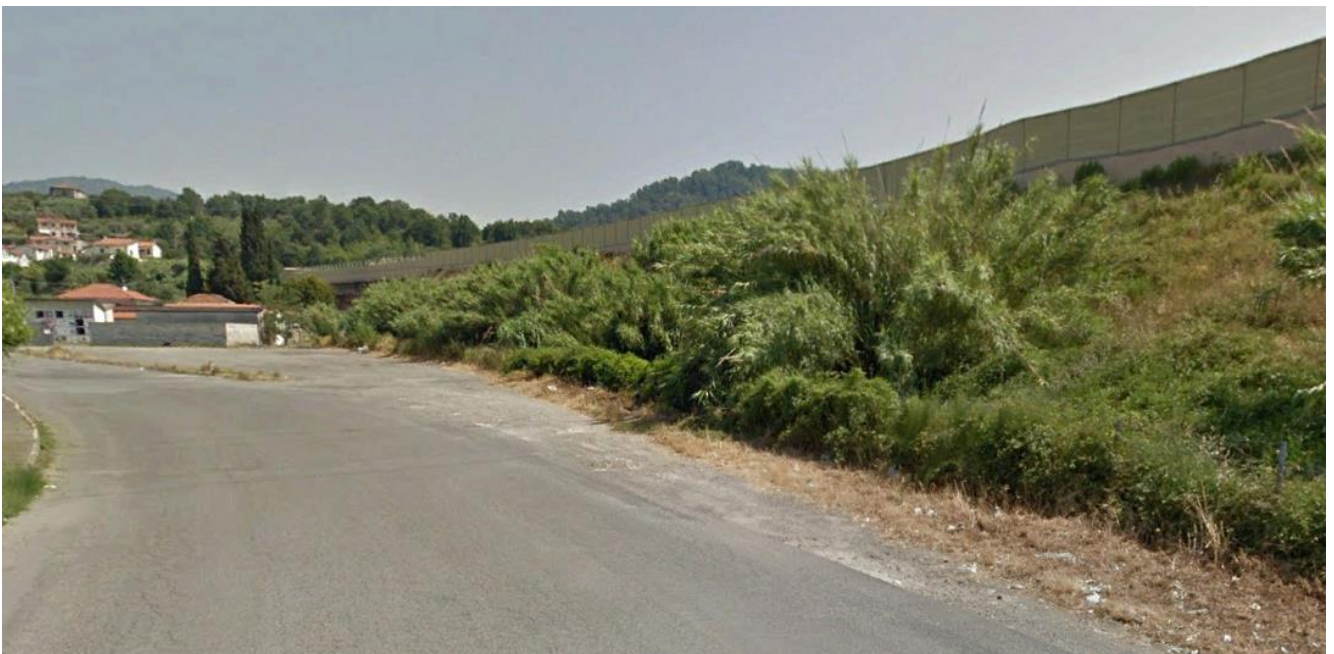
Figura 12: Foto lato Ovest della A15, in prossimità dell'area cimiteriale
