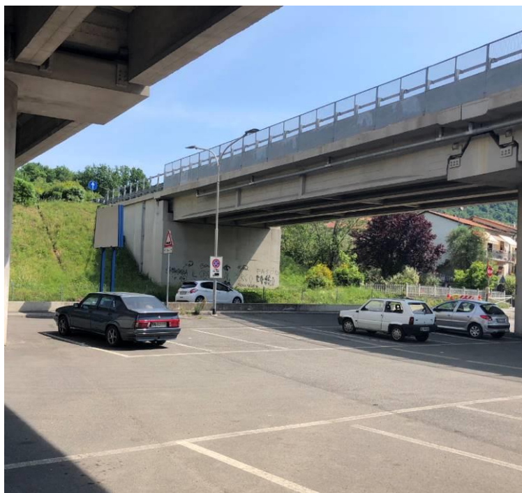
Figura 14: Foto sotto l'Autostrada A15
