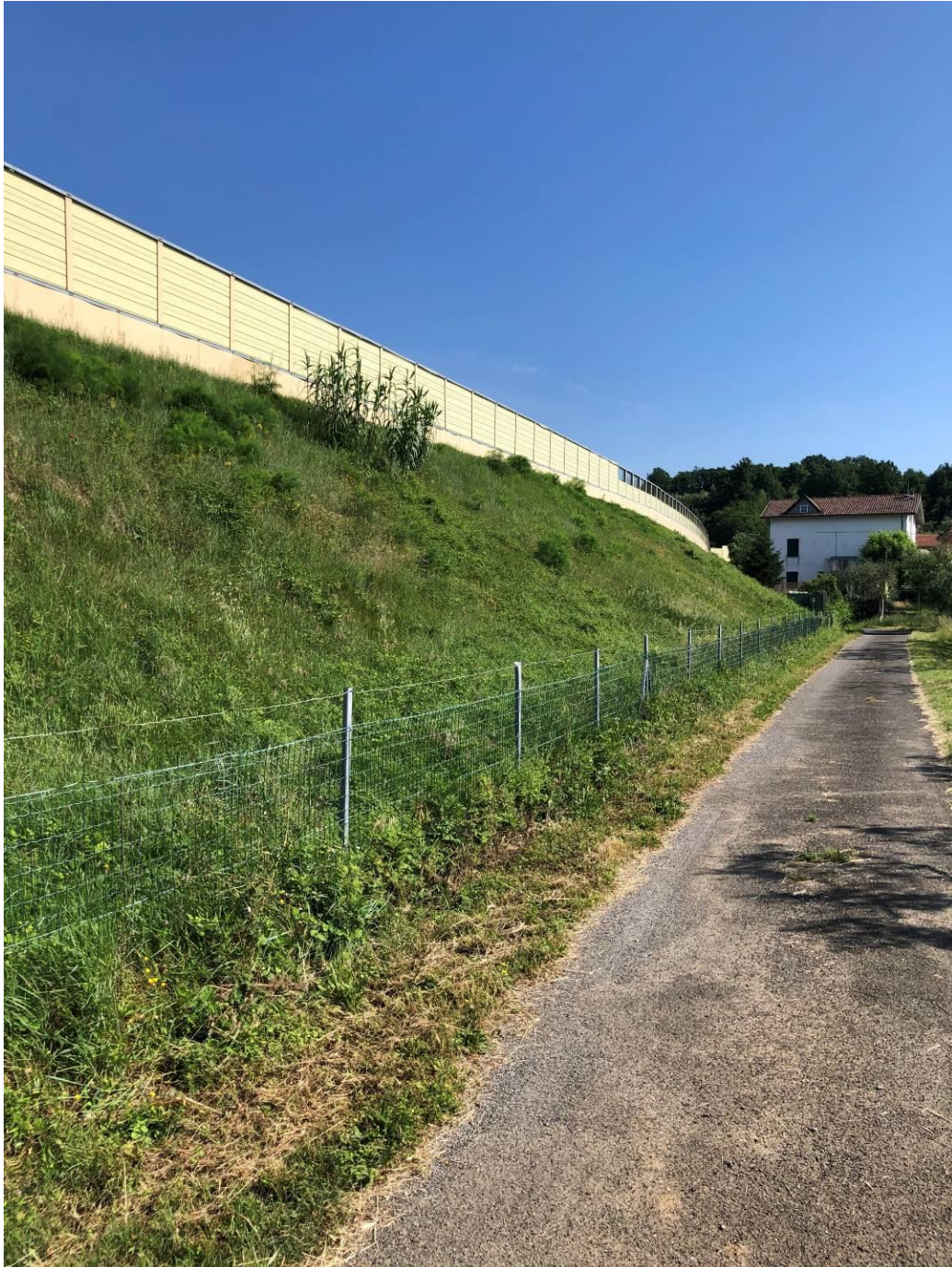
Figura 5: Foto lato Est della A15
