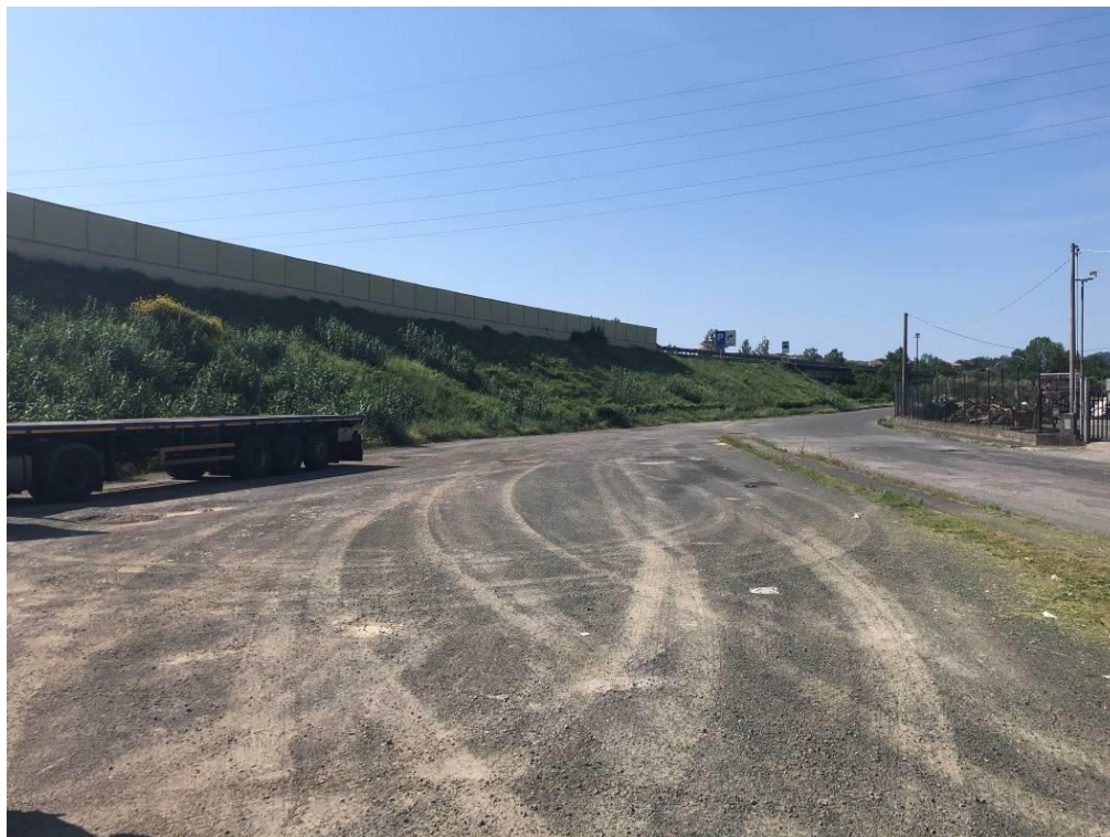
Figura 9: Foto lato Ovest della A15, in prossimità dell'area cimiteriale
