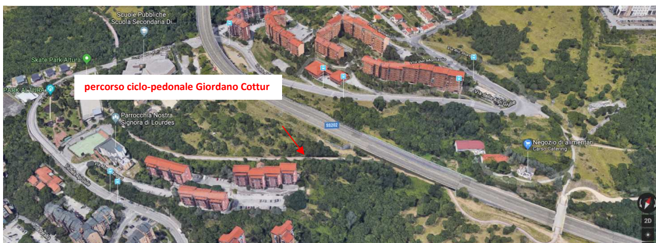
Fig. 5 - Vista 3D; in primo piano il viadotto della GVT che sovrappassa la pista ciclabile realizzata sulla ex ferrovia (percorso ciclo-pedonale Giordano Cottur) ed il sovrappasso carrabile per il traffico locale
