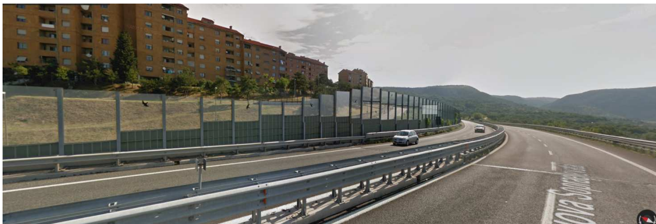
Fig. 6 - Vista della GVT in direzione Rabuiese nel tratto di intervento in rilevato di aggiramento del colle di Cattinara e del rione di Altura; si noti la presenza delle barriere fonoassorbenti
