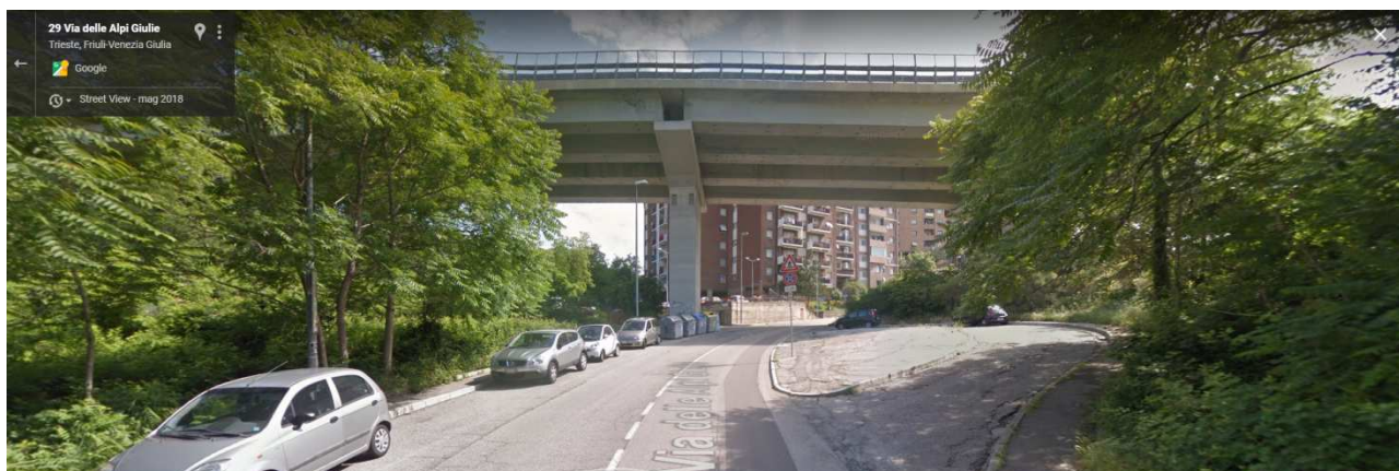
Fig.8 - Via Alpi Giulie nel tratto di sottopassaggio del viadotto della GVT
