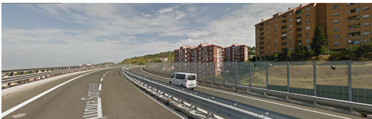
Fig. 7 - Vista della GVT in direzione Venezia nel tratto di intervento
