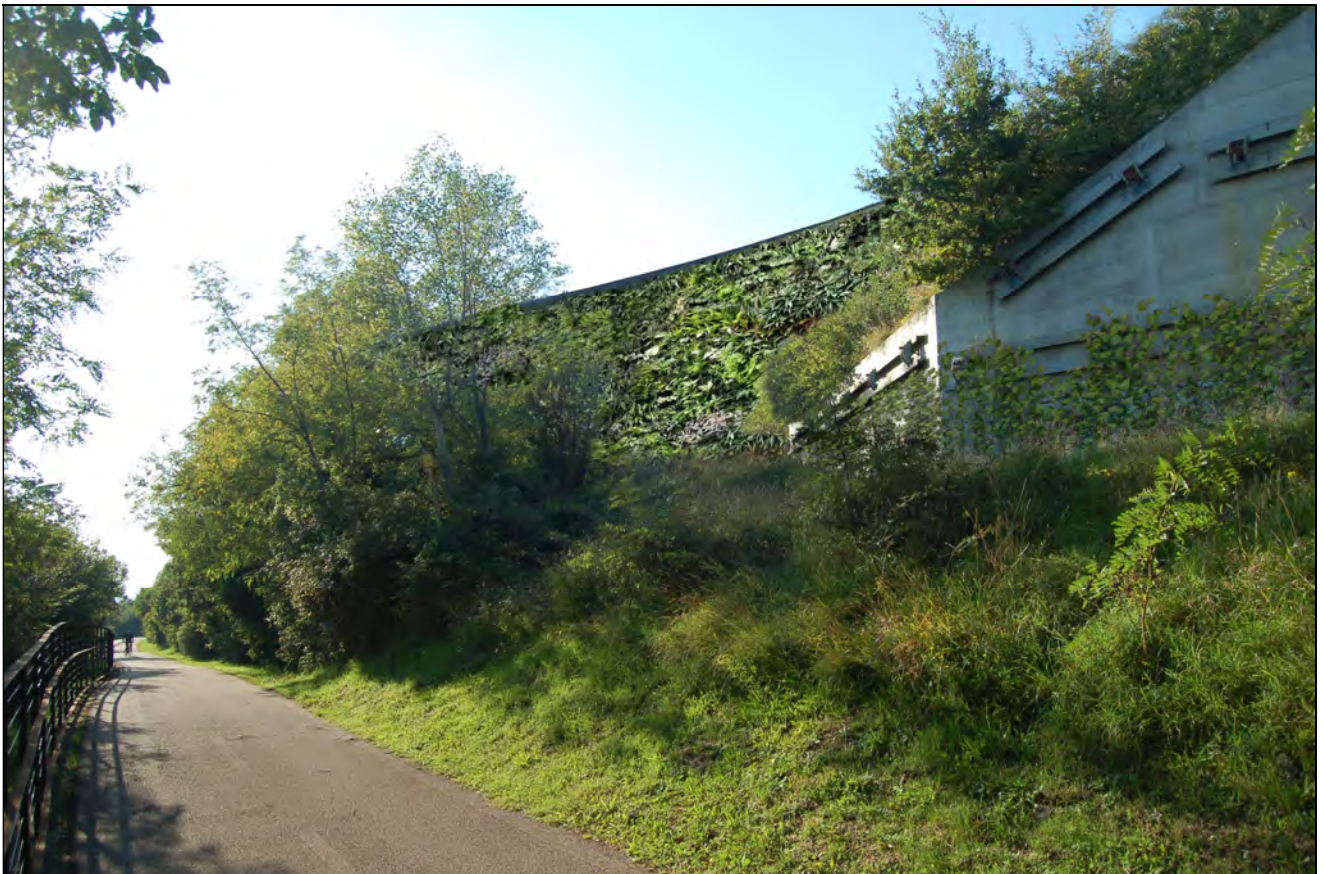
Punto di vista 3 - pista ciclopedonale Cottur nel punto più vicino al nuovo svincolo sulla GVT Opere di sostegno in terre armate - stato dopo 2/3 anni dalla fine lavori, con opere di mitigazione
