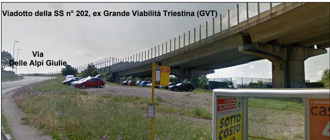
Lembi di vegetazione erbacea a graminacee nella zona posta sotto il viadotto della GVT
