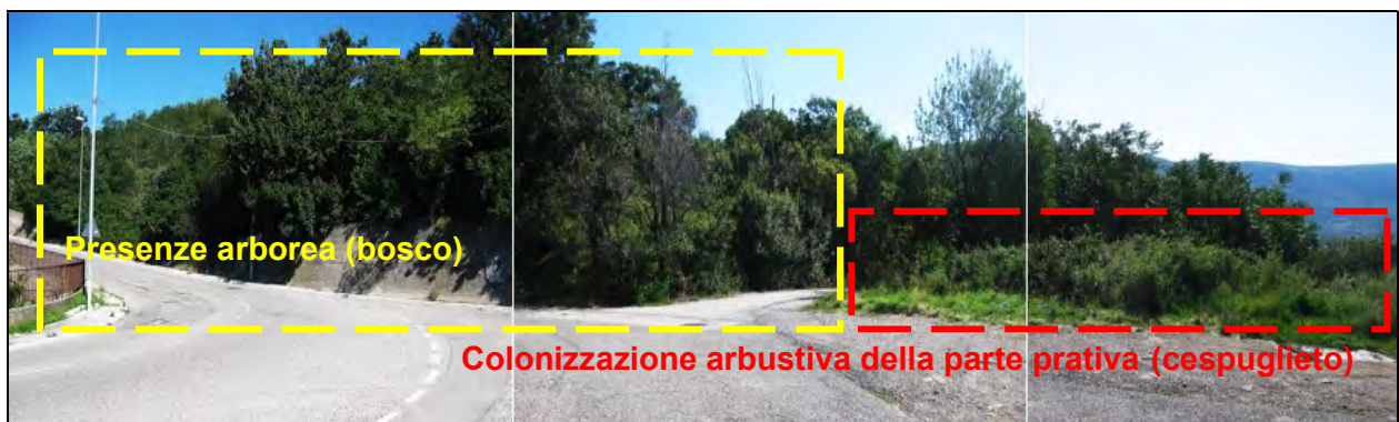
Tornante in Via delle Alpi Giulie con annesso slargo stradale ed imbocco della strada che porta all'ingresso secondario del complesso ospedaliero (zona del depuratore)
