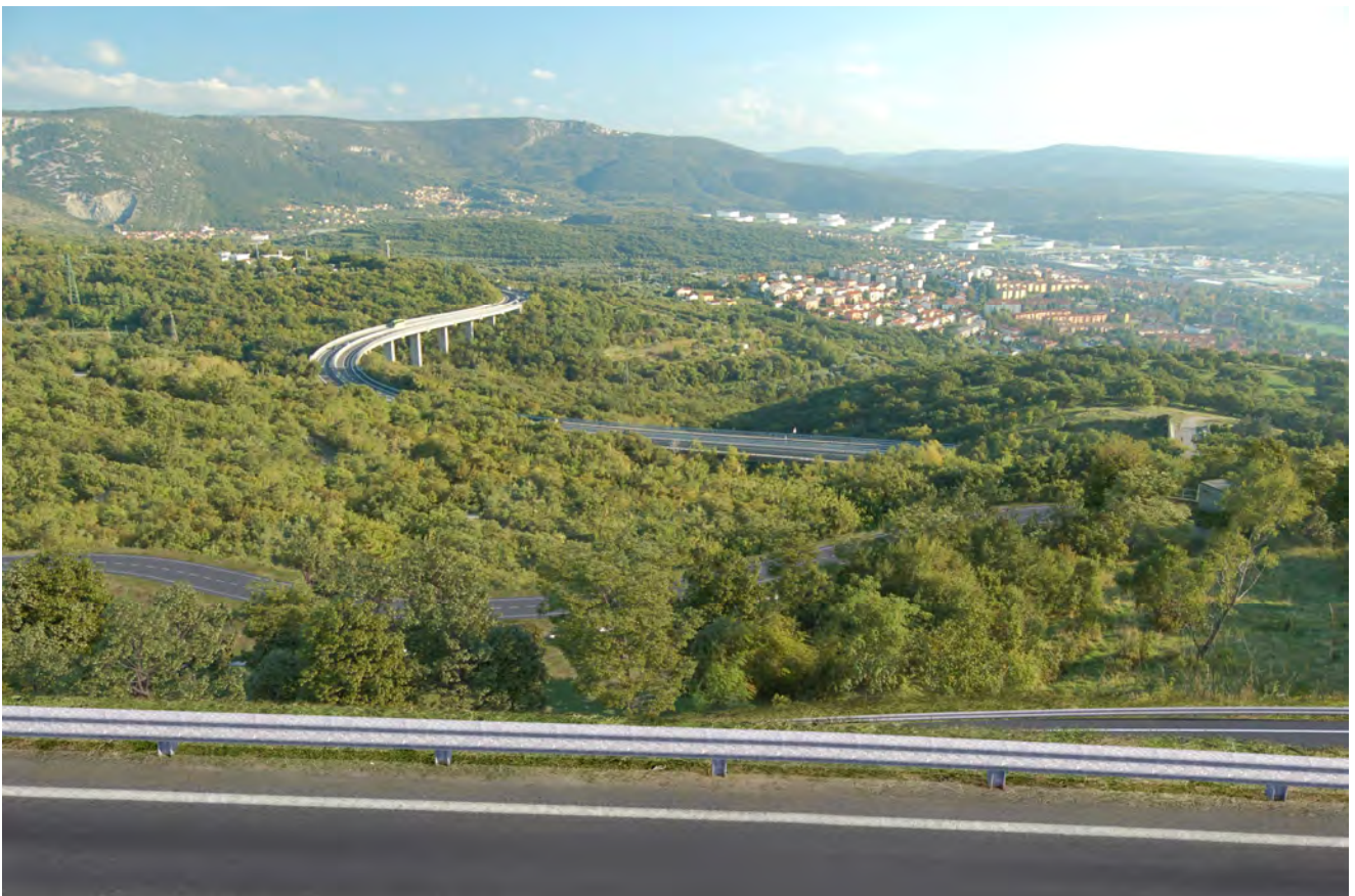
Punto di vista 5 - Versante boscato dal piazzale del parcheggio del Polo Cardiologico - stato a 4/5 anni dalla fine lavori, con opere di mitigazione
