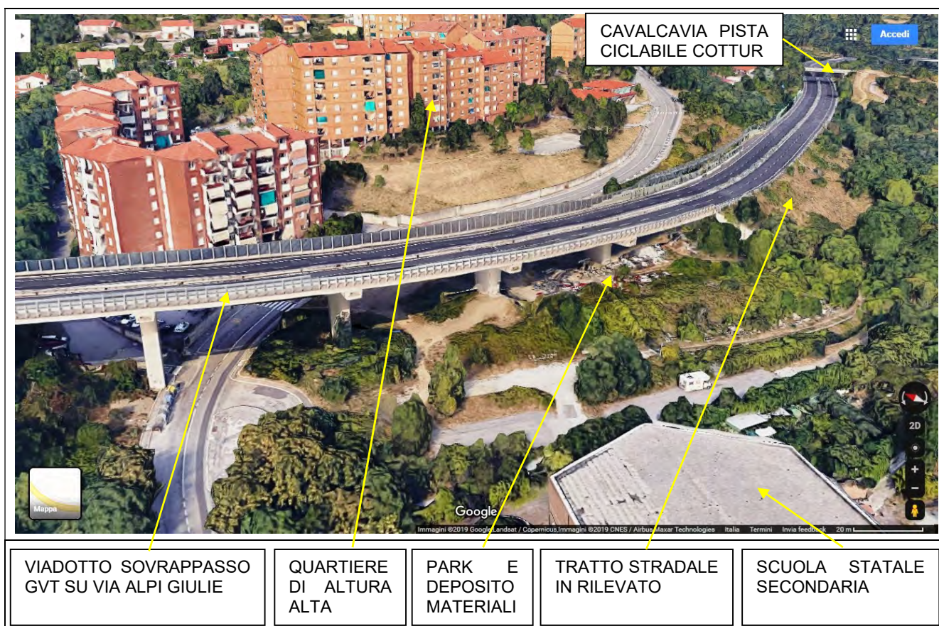
Ambito A del nuovo svincolo lungo la GVT
