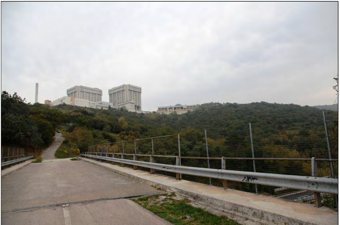
Ambito B del nuovo svincolo lungo la GVT - p.d.v.6 entro il perimetro di vincolo: cavalcavia sulla GVT (ora pista Cottur) e versante sud di Cattinara
