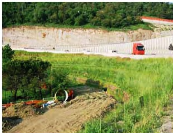
Foto 14 - Esempio di prerinverdimento: costruzione e rinverdimento di terre rinforzate verdi (GVT – curva di Cattinara – Foto G. Sauli)
