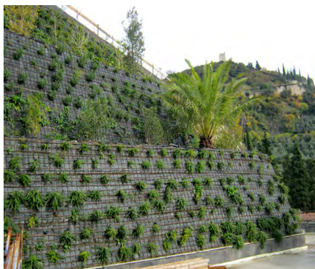
Esempio di terre rinforzate con inserimento di specie tapezzanti sul piano inclinato ed arbusti sul gradone
