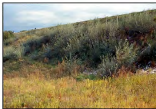
Foto 435 - Piantagione di arbusti autoctoni e talle di salici arbustivi pionieri ( Salix elaeagnos , S. purpurea ) a gradonata su rilevato autostradale su ghiaie calcaree da scavi privo di suolo vegetale Carso triestino Loc. Aurisina (GVT - TS) – Foto G. Sauli 1991
