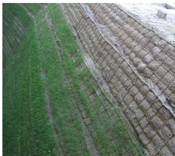
Esempio di terre rinforzate con una parte inerbita ed una da inerbitare
