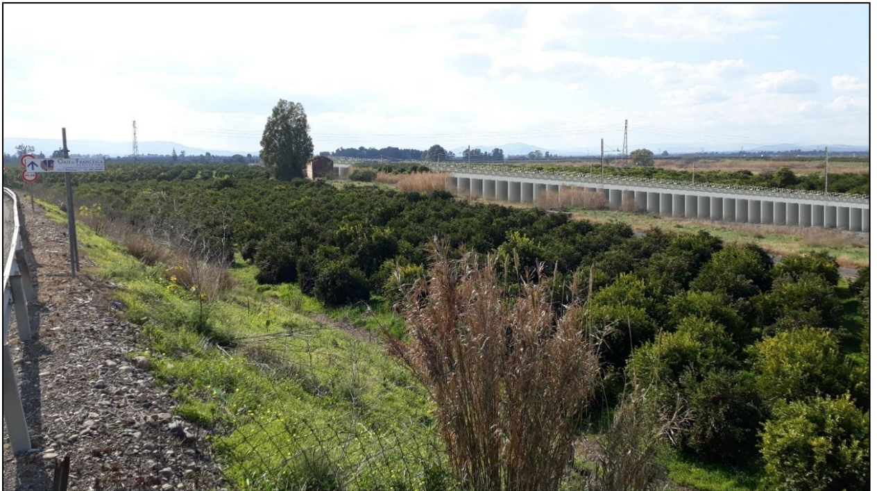
Figura 21 – Stato dei luoghi - fotoinserimento gallerodotto 2
