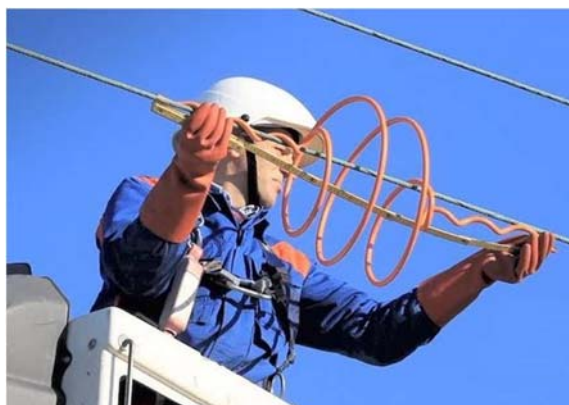
Figura 7 – Montaggio di una spirale
