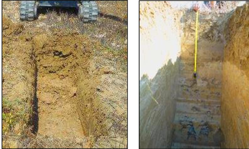
Figura 3: dettaglio foto fase di scavo superficiale (a sx) ed esempio di profilo pedologico (a dx)
