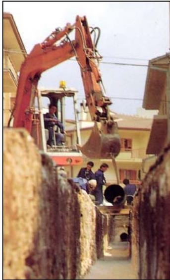
**Figura 10: Apertura di una trincea per la posa del metanodotto**
