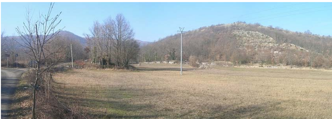
Figura 6.k: Vista dell'area di Accesso alla Camera Valvole
