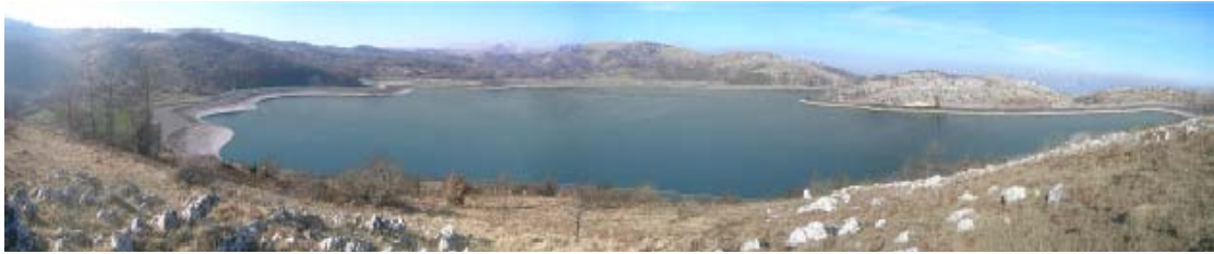
Figura 3.c: Impianto Idroelettrico, Bacino Superiore di Monte Alto
