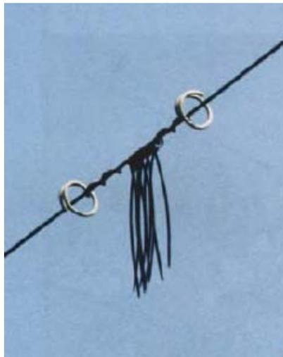
**Figura 6.g: Marker Utilizzati come Sistemi di Dissuasione Visiva sui Conduttori di un Elettrodotto ad Alta Tensione**
