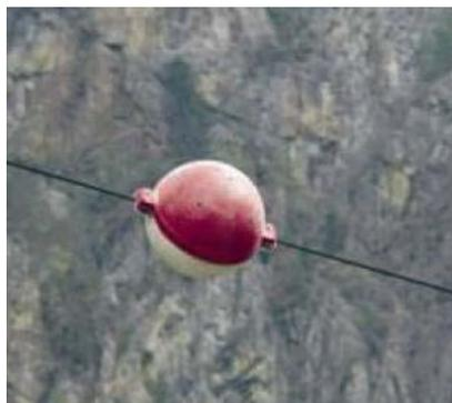
**Figura 6.h: Sfere di Poliuretano Utilizzate come Sistemi di Dissuasione Visiva sui Conduttori di un Elettrodotto ad Alta Tensione**
