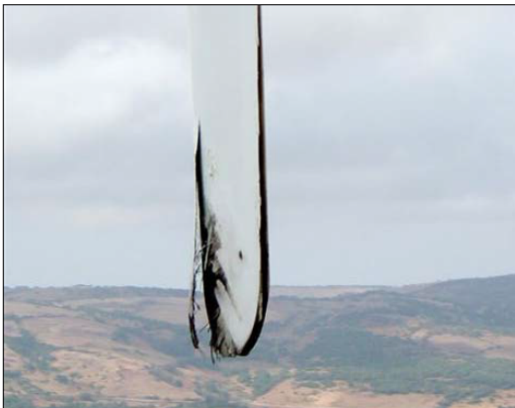
Estremità della pala danneggiata da fulminazione atmosferica
