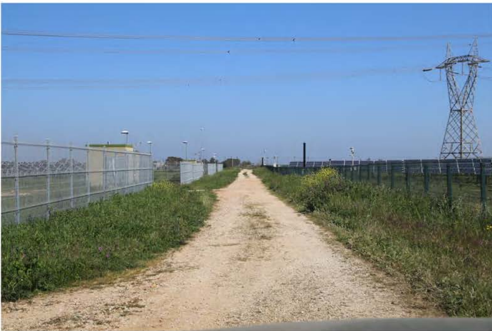
IMG_3131_Strada Comunale 54_accesso SSE.JPG
