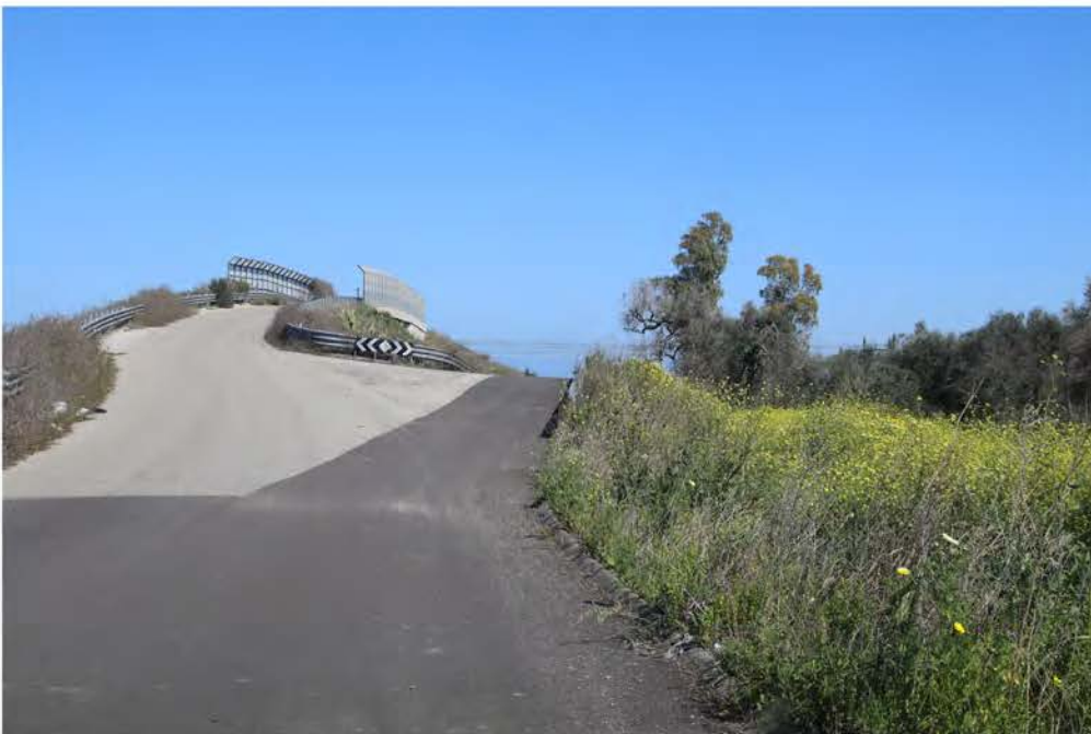
IMG_2899_CAVIDOTTO SA SPV 04 A SPV 05 (23A).JPG
