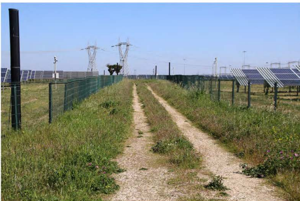
IMG_3127_Strada Comunale 54_accesso SSE.JPG
