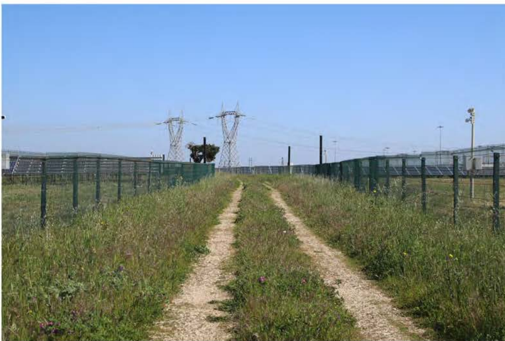
IMG_3128_Strada Comunale 54_accesso SSE.JPG
