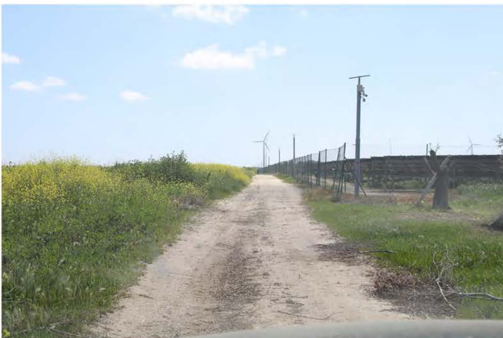
IMG_2892_CAVIDOTTO DA SPV 03 A SPV 04.JPG
