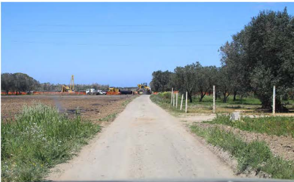
IMG_2899_CAVIDOTTO SA SPV 04 A SPV 05 (38).JPG
