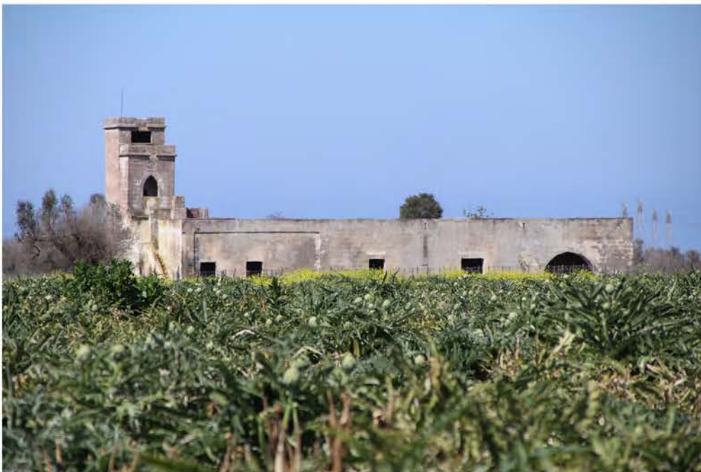
IMG_2972_ACCESO E AEREA PIAZZOLA SPV 07_MASS TRAMAZZONELLO.JPG
