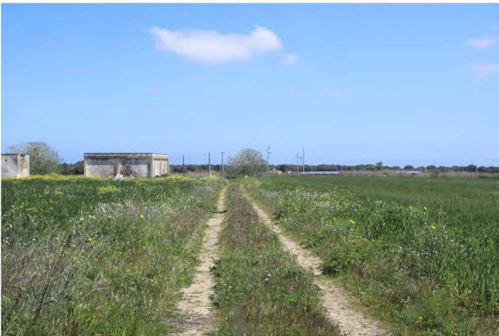
IMG_2875_CAVIDOTTO DA SPV 03 A SPV 04.JPG
