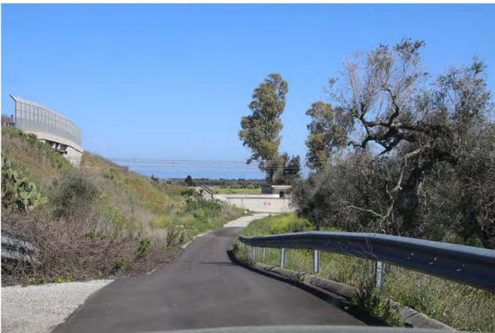
IMG_2899_CAVIDOTTO SA SPV 04 A SPV 05 (23B).JPG
