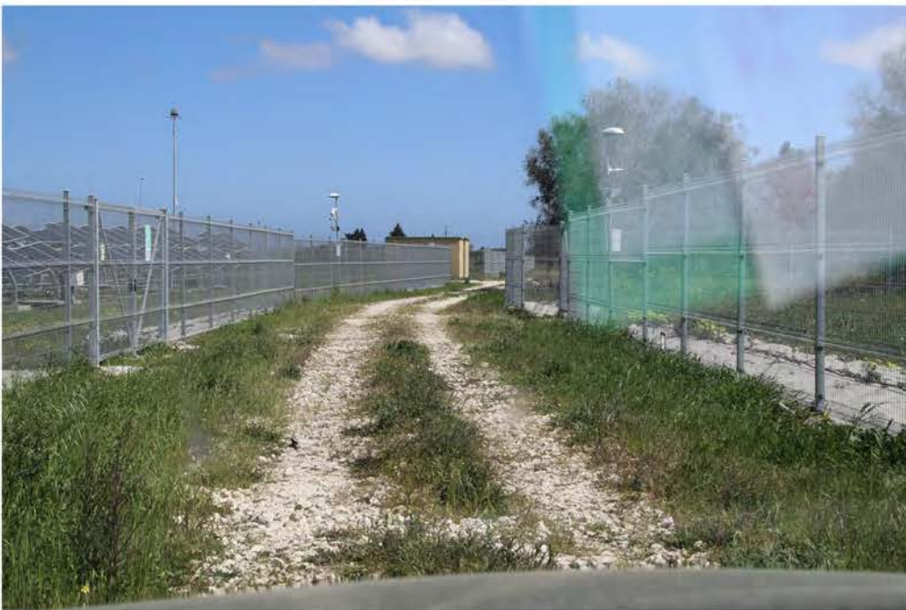
IMG_2899_CAVIDOTTO SA SPV 04 A SPV 05 (15).JPG
