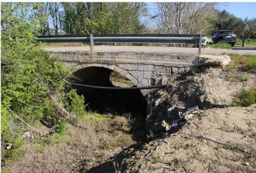
IMG_3068_Strada Comunale 23_Strada Poderale Santa Filomena_PONTE.JPG
