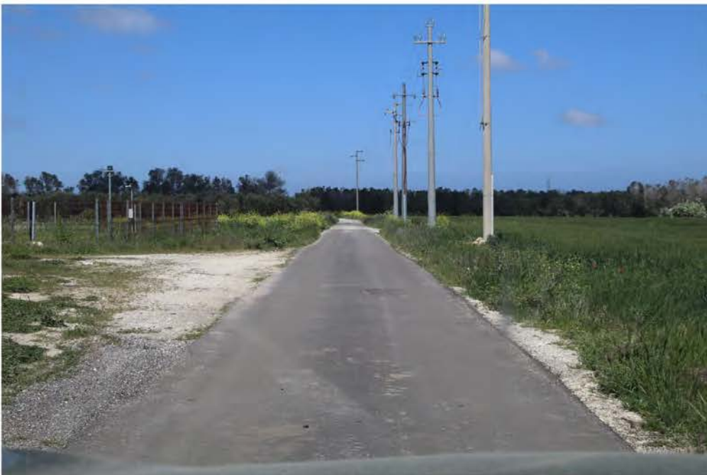
IMG_2899_CAVIDOTTO SA SPV 04 A SPV 05 (27).JPG
