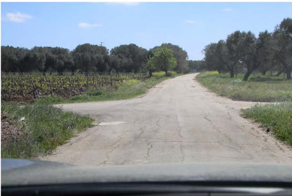
IMG_2886_CAVIDOTTO DA SPV 03 A SPV 04.JPG
