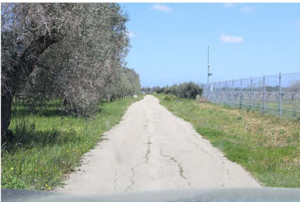
IMG_2889_CAVIDOTTO DA SPV 03 A SPV 04.JPG
