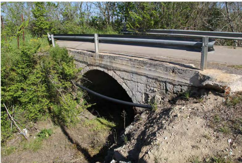
IMG_3067_Strada Comunale 23_Strada Poderale Santa Filomena_PONTE.JPG
