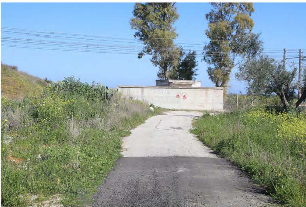
IMG_2899_CAVIDOTTO SA SPV 04 A SPV 05 (23C).JPG
