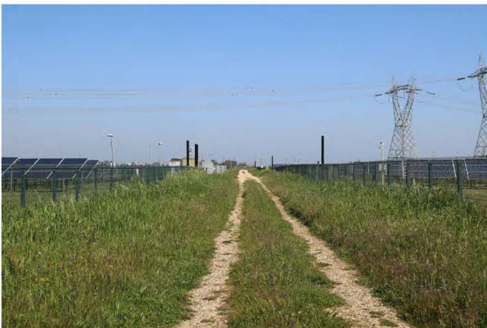
IMG_3130_Strada Comunale 54_accesso SSE.JPG
