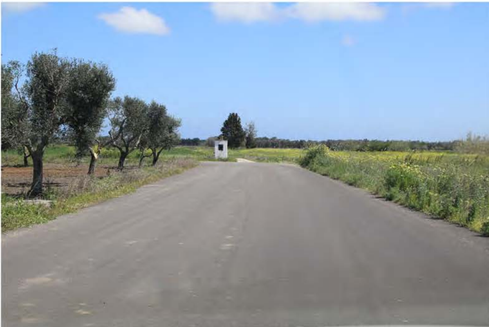
IMG_2899_CAVIDOTTO SA SPV 04 A SPV 05 (24).JPG
