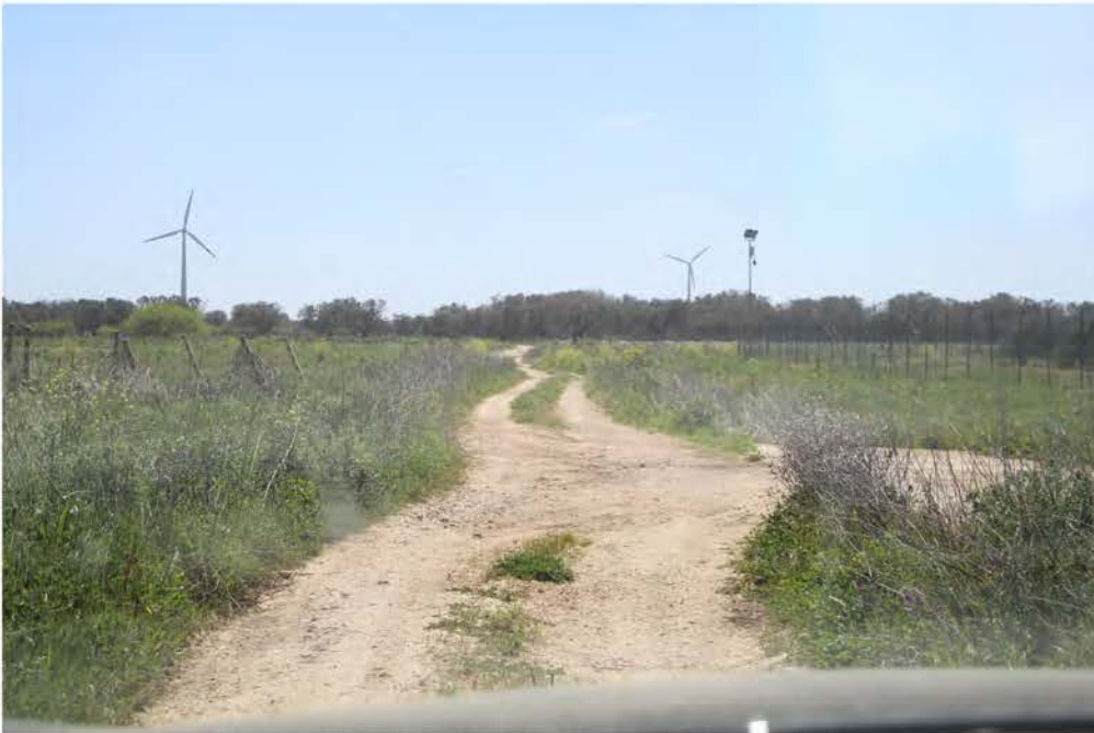
IMG_2899_CAVIDOTTO SA SPV 04 A SPV 05 (8).JPG
