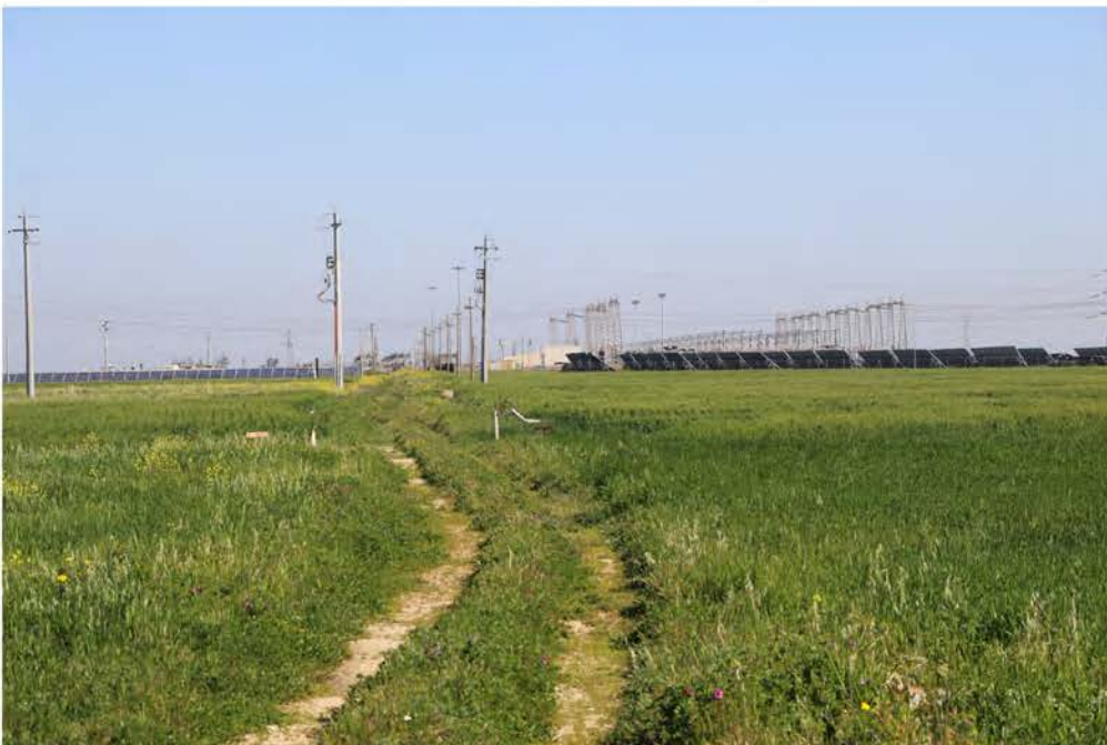
IMG_3104_Strada Comunale 54_accesso SSE.JPG
