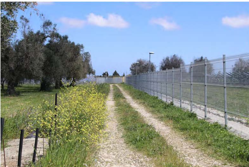
IMG_2899_CAVIDOTTO SA SPV 04 A SPV 05 (14).JPG
