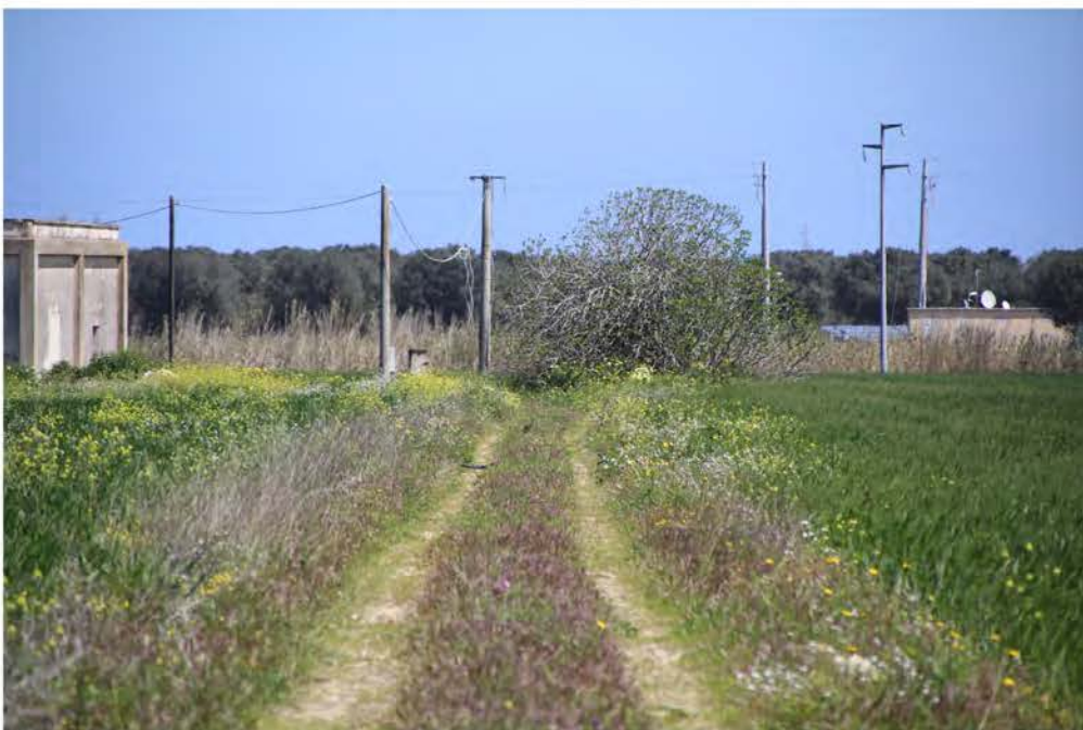
IMG_2873_CAVIDOTTO DA SPV 03 A SPV 04.JPG
