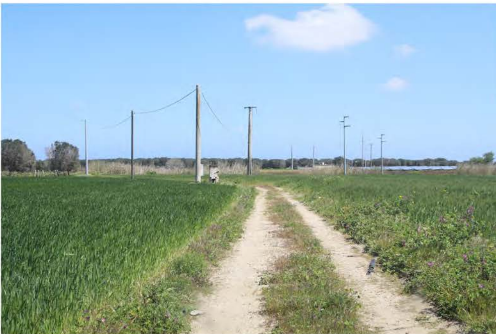
IMG_2877_CAVIDOTTO DA SPV 03 A SPV 04.JPG
