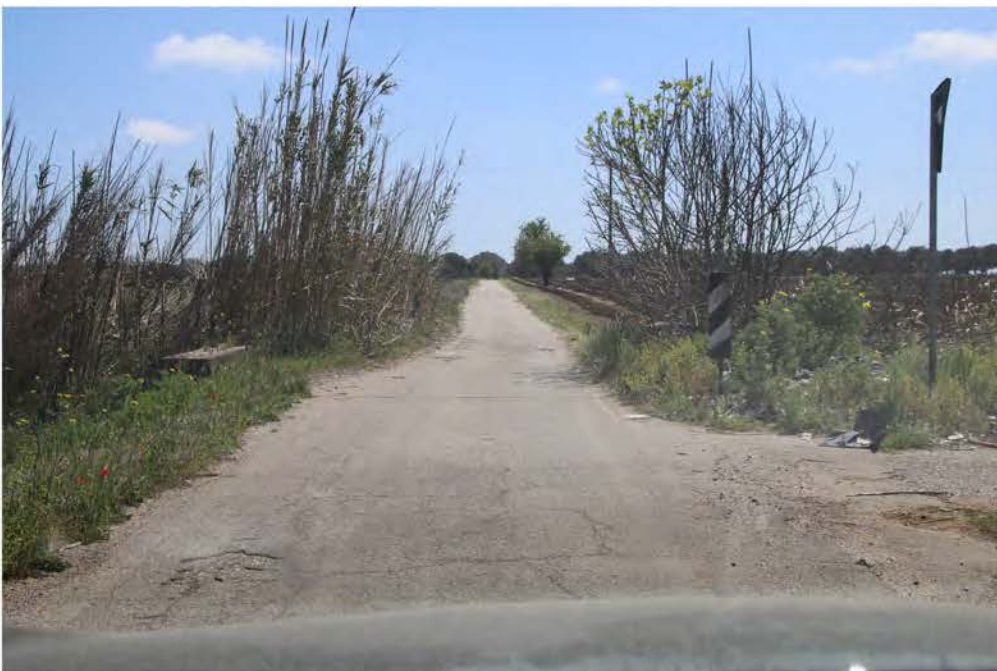
IMG_2883_CAVIDOTTO DA SPV 03 A SPV 04.JPG
