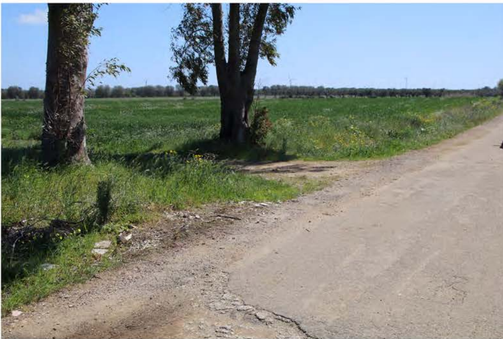
IMG_2850_ACCESO A CAVIDOTTO DA STRADA BARDI NUOVI.JPG
