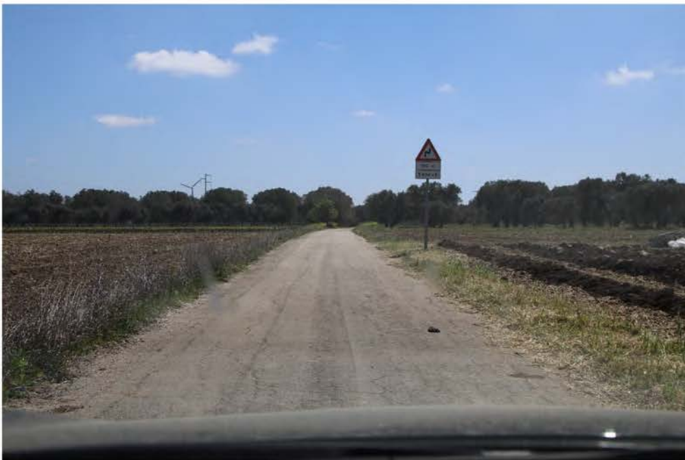
IMG_2885_CAVIDOTTO DA SPV 03 A SPV 04.JPG
