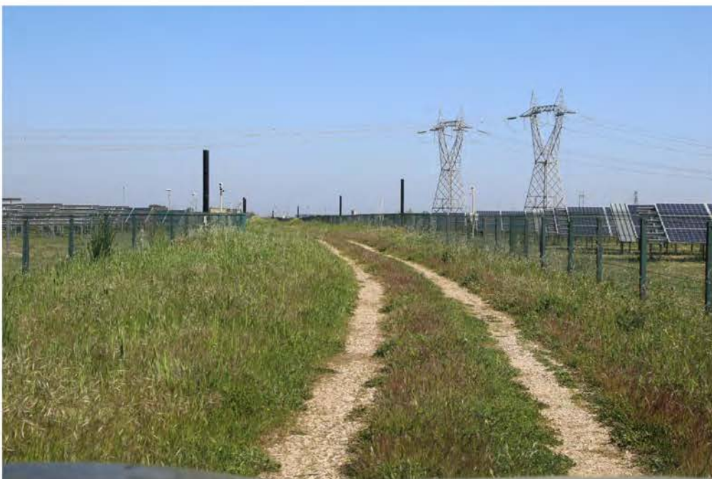
IMG_3129_Strada Comunale 54_accesso SSE.JPG
