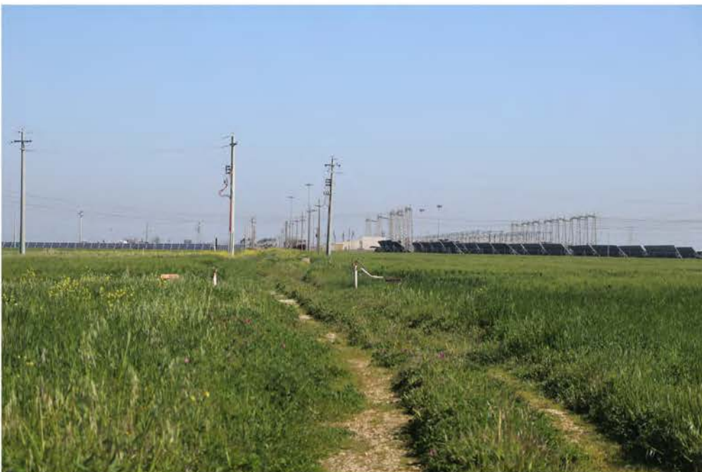
IMG_3105_Strada Comunale 54_accesso SSE.JPG
