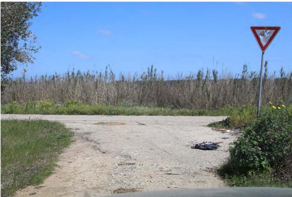
IMG_2882_CAVIDOTTO DA SPV 03 A SPV 04.JPG
