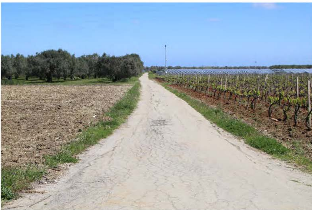
IMG_2887_CAVIDOTTO DA SPV 03 A SPV 04.JPG
