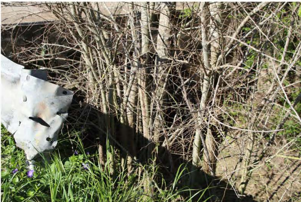
IMG_3066_Strada Comunale 23_Strada Poderale Santa Filomena_PONTE.JPG
