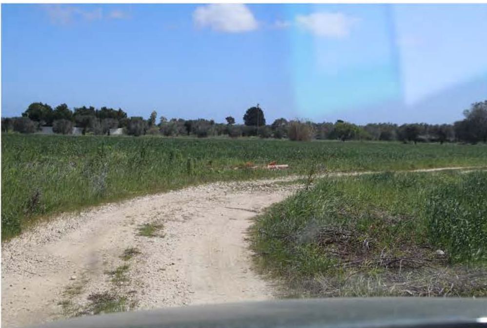
IMG_2899_CAVIDOTTO SA SPV 04 A SPV 05 (17).JPG
