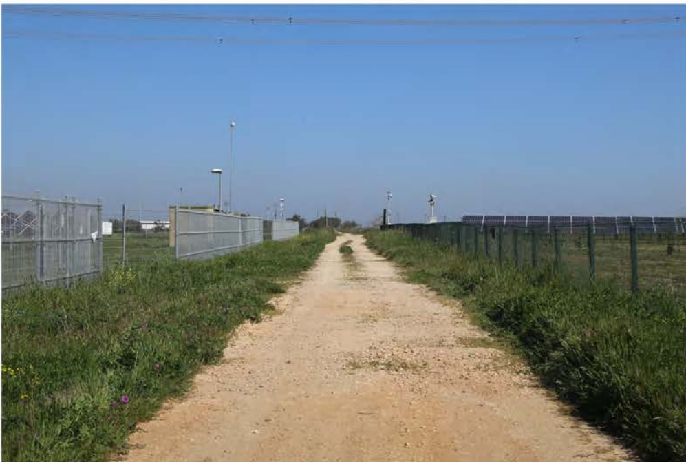
IMG_3132_Strada Comunale 54_accesso SSE.JPG
