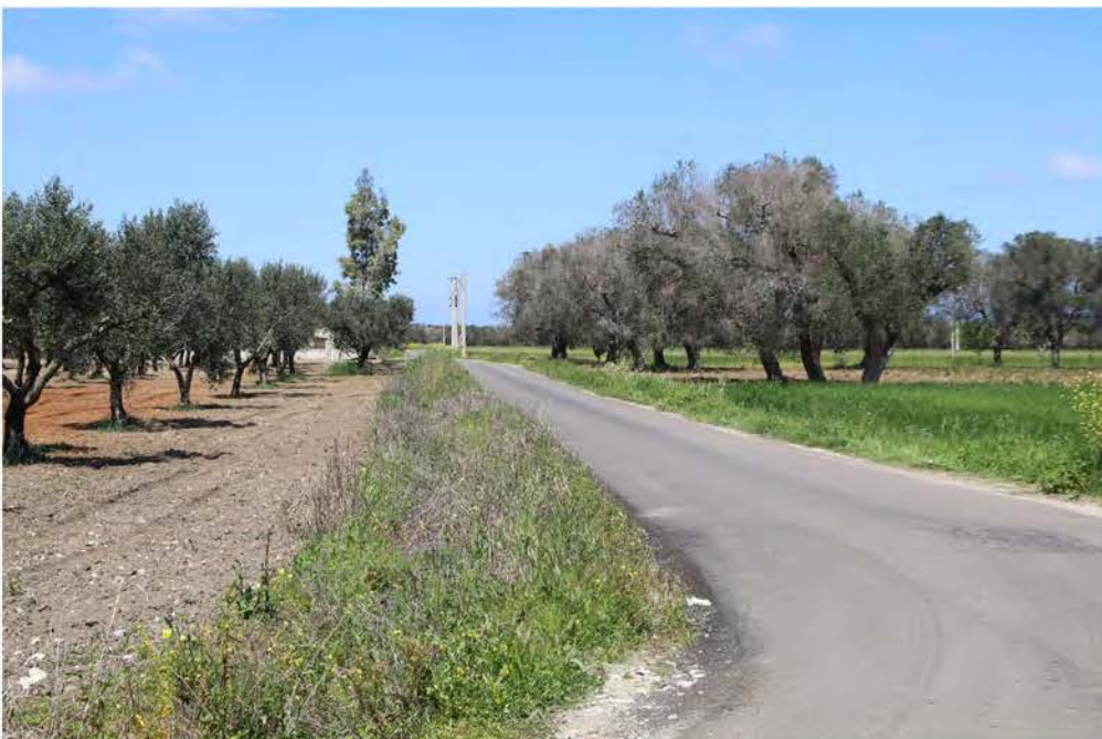
IMG_2899_CAVIDOTTO SA SPV 04 A SPV 05 (25).JPG
