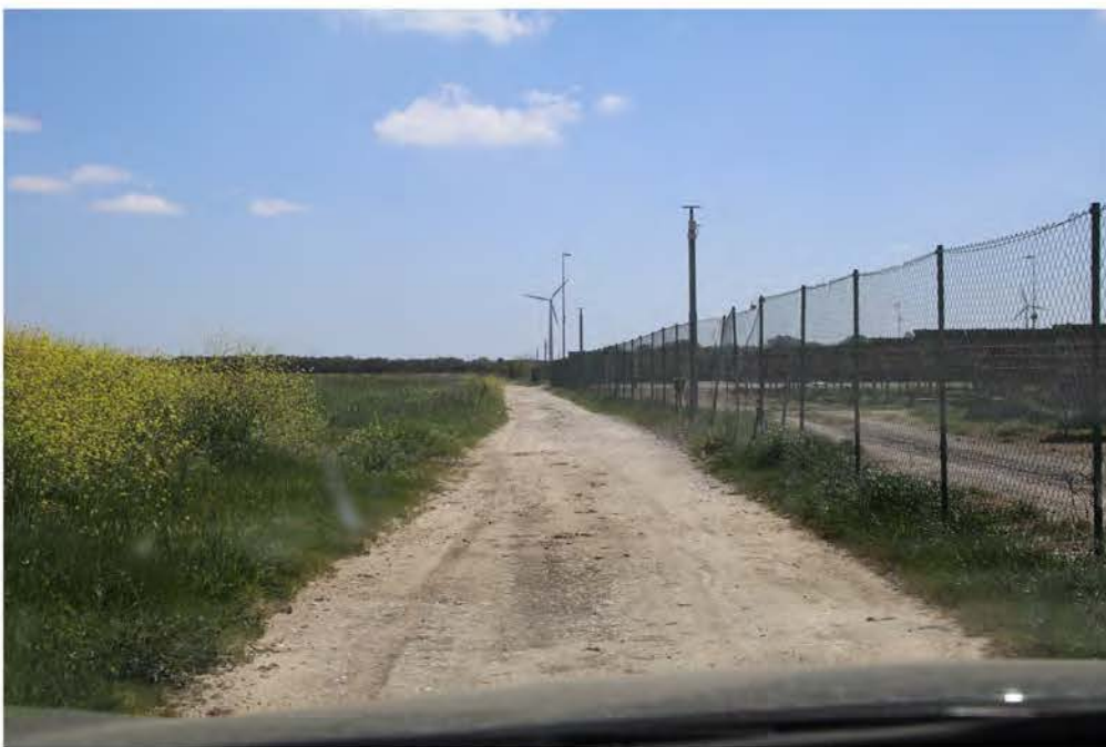
IMG_2893_CAVIDOTTO DA SPV 03 A SPV 04.JPG
