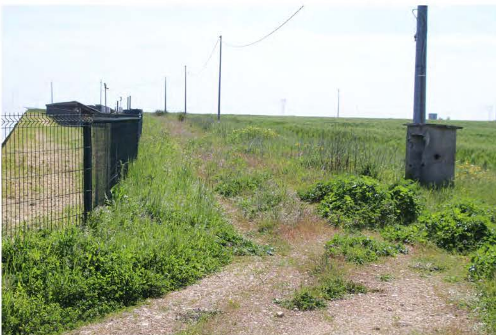
IMG_3126_Strada Comunale 54_accesso SSE.JPG
