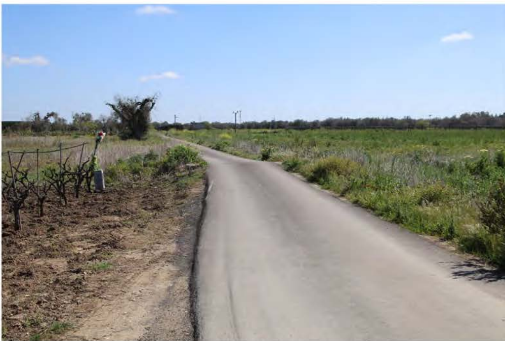
IMG_3003_CAVIDOTTO DA FOTO 3003 A SPV 10.JPG
