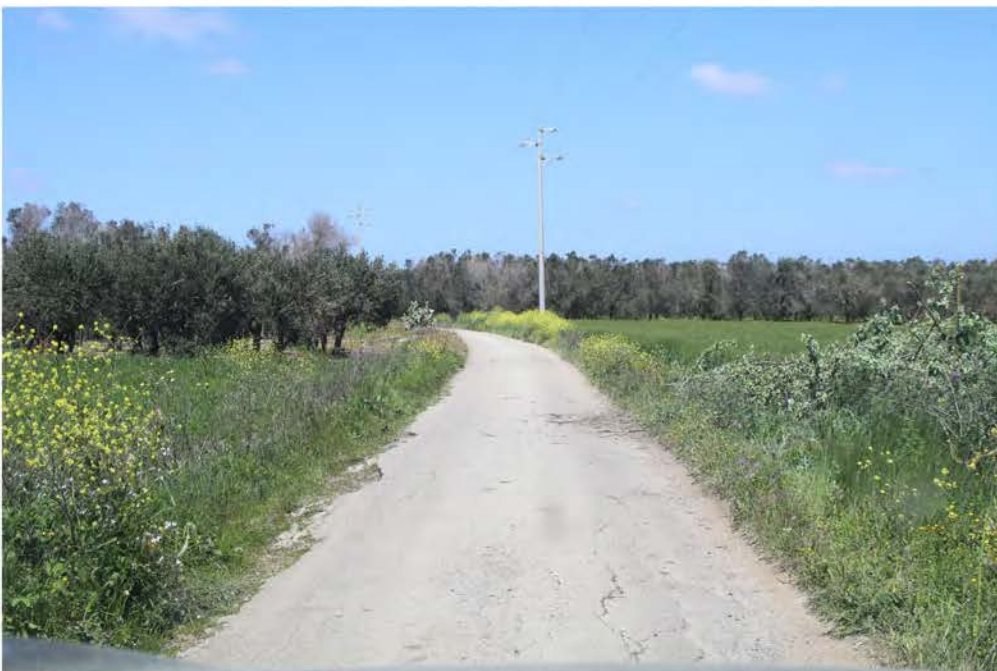
IMG_2899_CAVIDOTTO SA SPV 04 A SPV 05 (28).JPG
