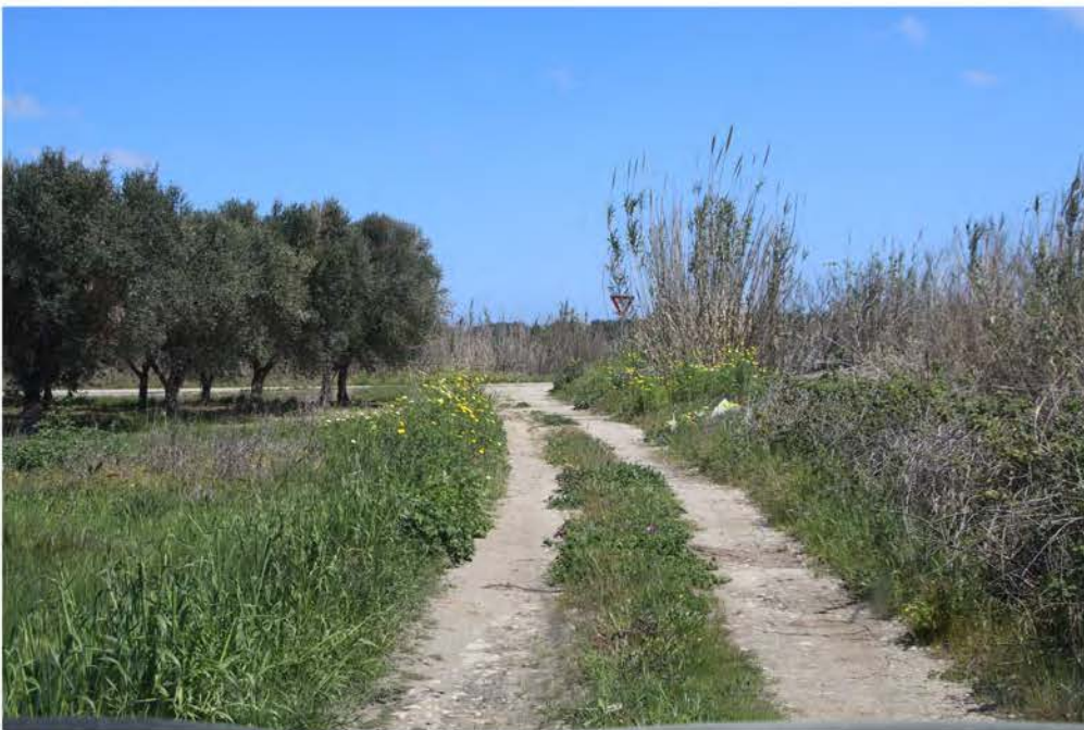
IMG_2881_CAVIDOTTO DA SPV 03 A SPV 04.JPG
