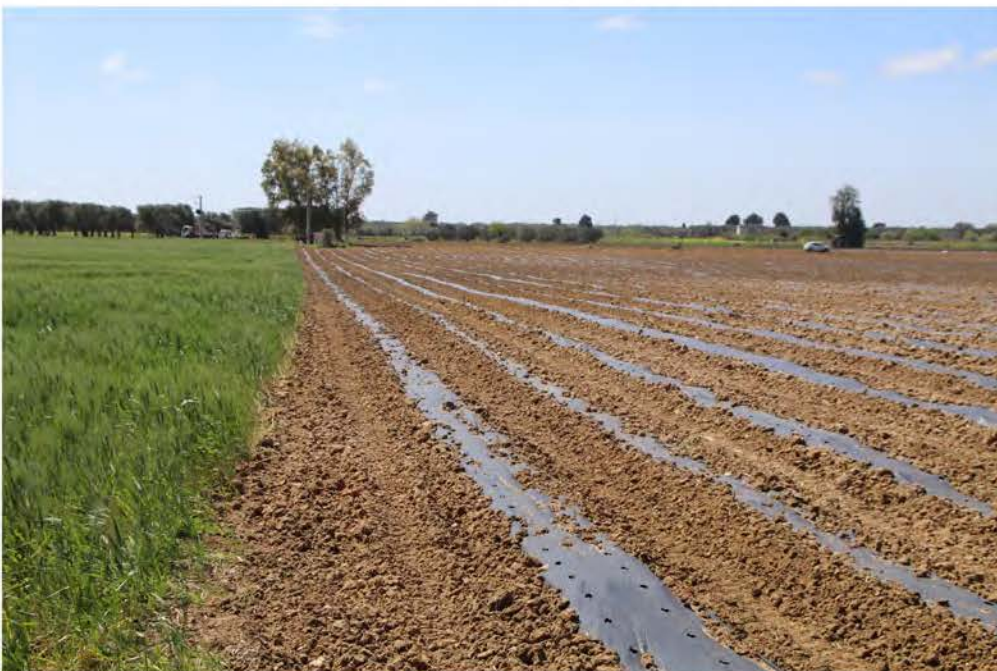
IMG_2899_CAVIDOTTO SA SPV 04 A SPV 05 (41).JPG
