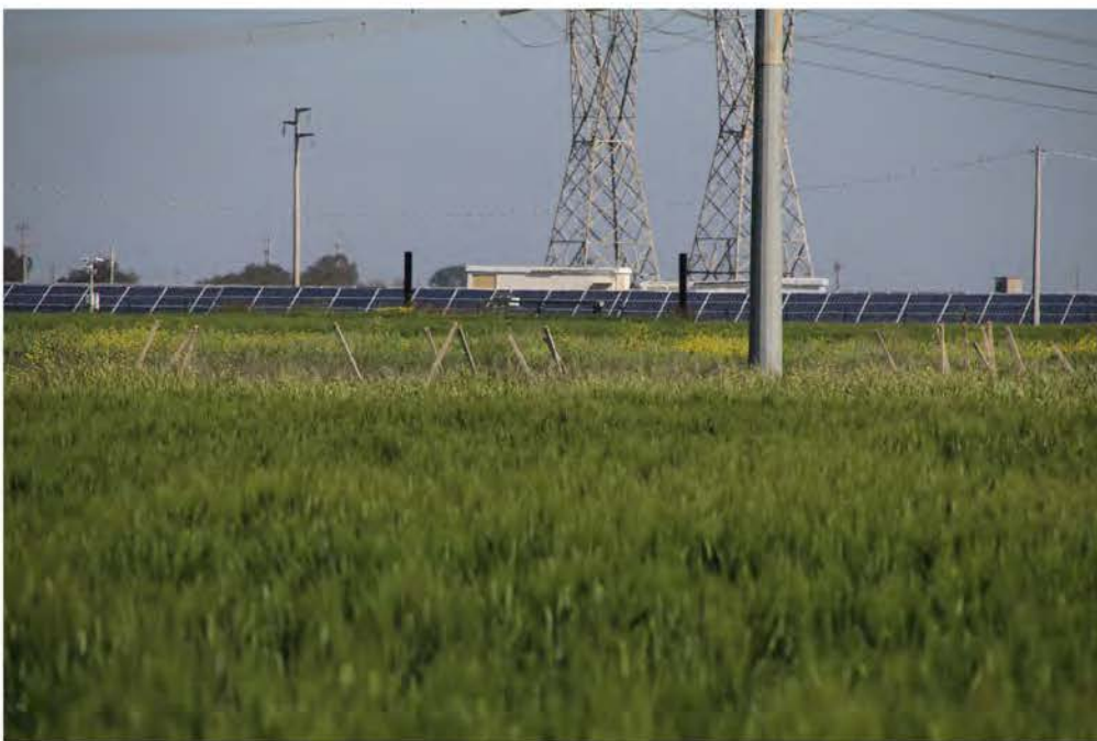
IMG_3110_Strada Comunale 54_accesso SSE.JPG
