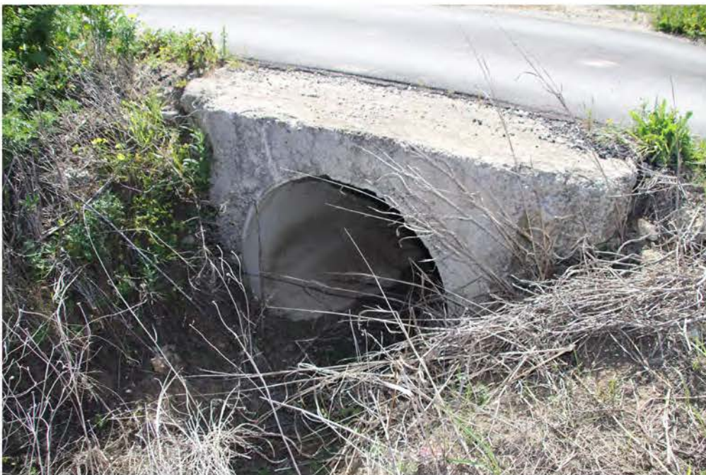
IMG_3005_CAVIDOTTO DA FOTO 3003 A SPV 10.JPG
