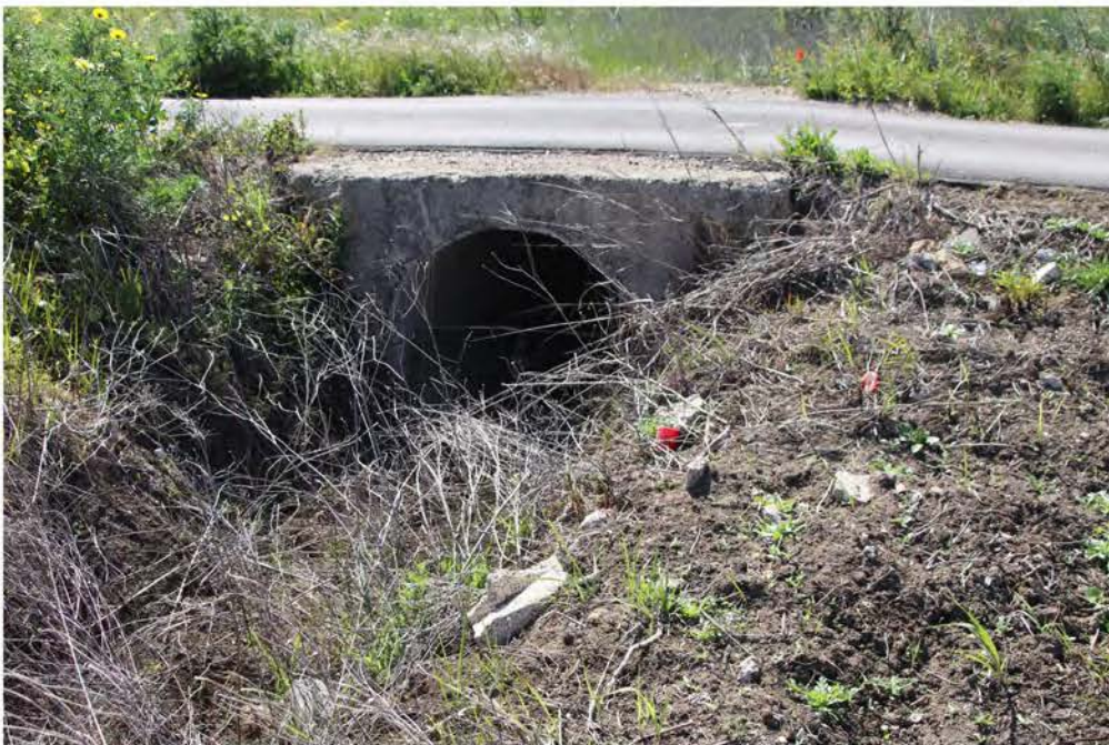
IMG_3004_CAVIDOTTO DA FOTO 3003 A SPV 10.JPG
