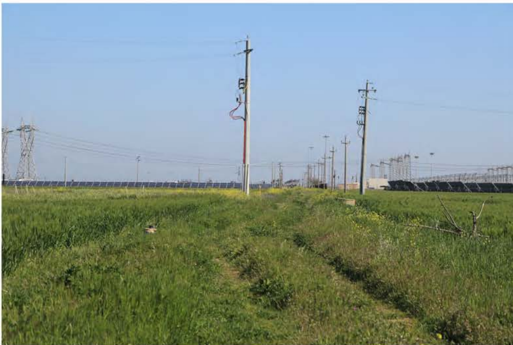
IMG_3107_Strada Comunale 54_accesso SSE.JPG
