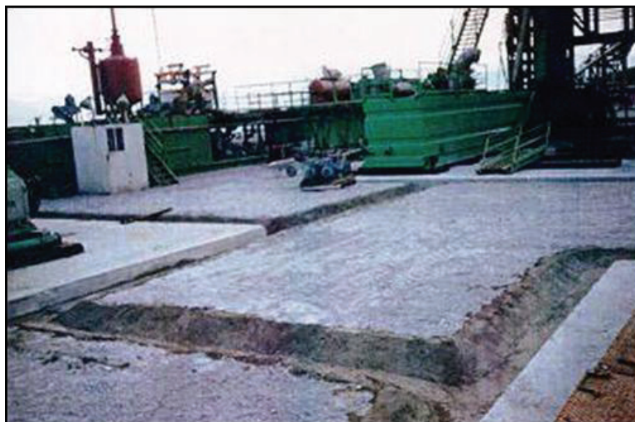
Figura 2.5: Predisposizione canalette grigliate perimetrali solette in cls.
