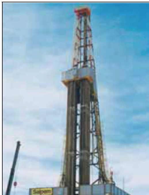
Figura 2.9: Impianto SAIPEM – EMSCO C2
