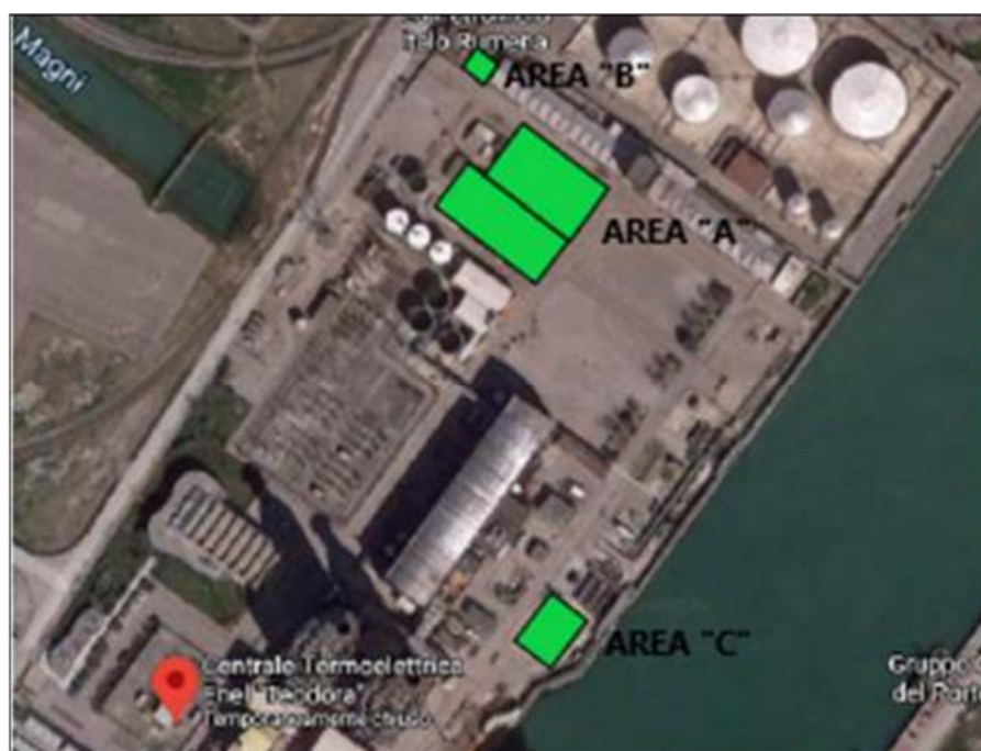
Aree di Cantiere
