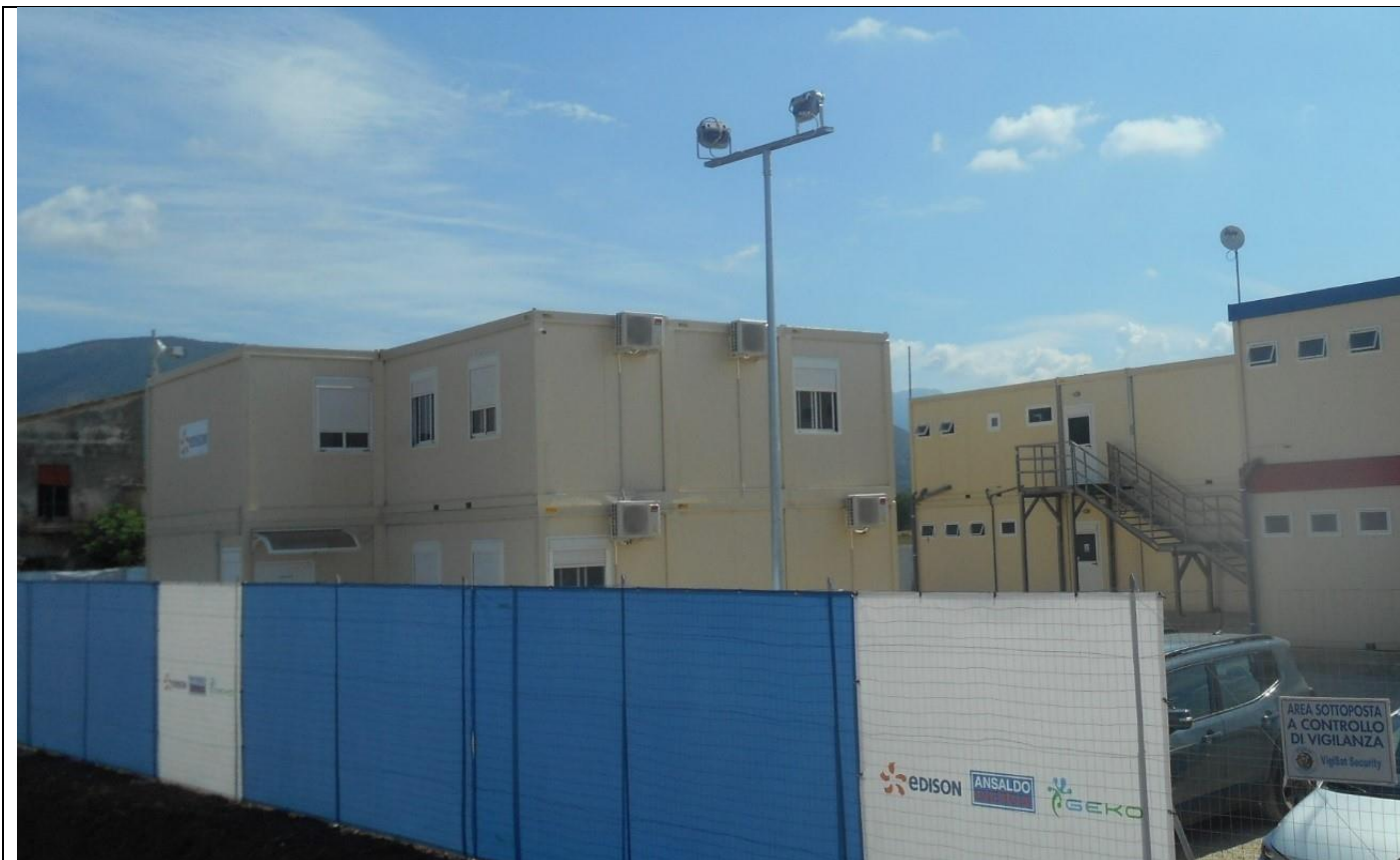
Area di cantiere
