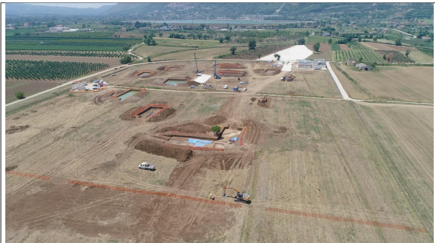
Area di costruzione
