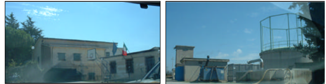
Scuola e depuratore nei pressi del torrente Acquatraversa
