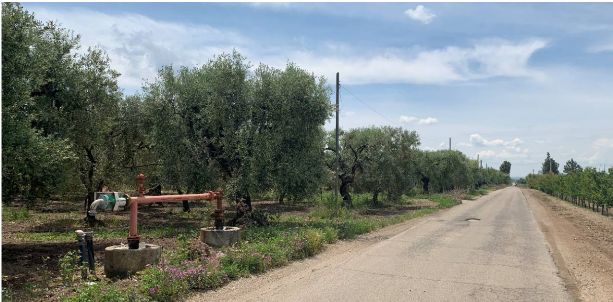
Foto P19.1: Vista della viabilità secondaria interessata dal passaggio del cavidotto esterno, in prossimità della sottostazione
