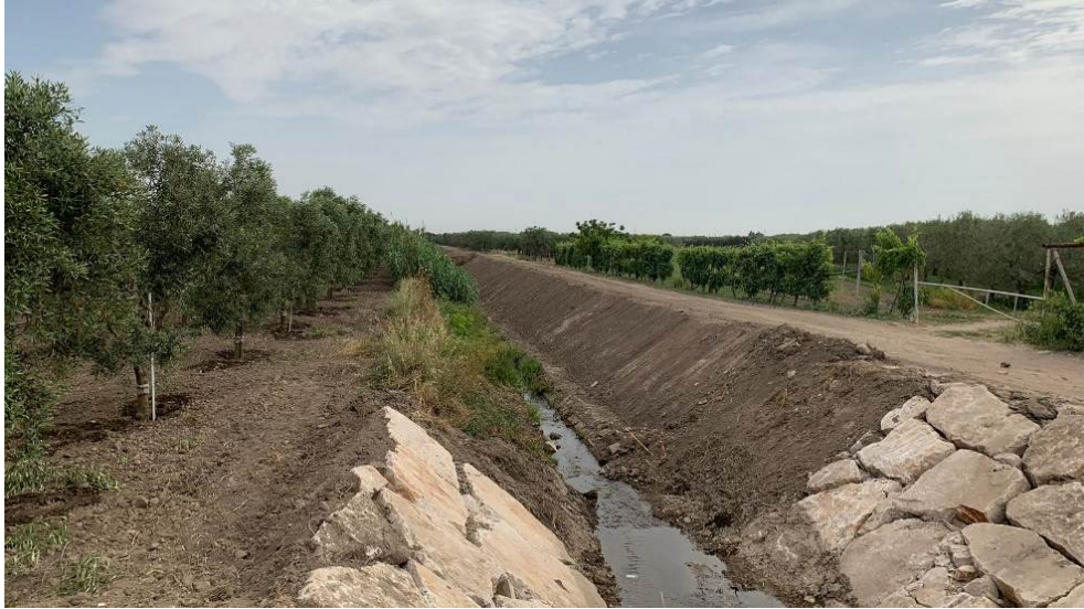
Foto P18.1: Marana La Pidocchiosa, in prossimità dell'attraverso del cavidotto esterno, in direzione nord
