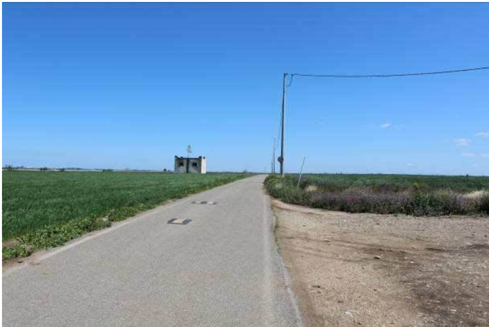
Foto P15.2: Vista dalla SP87 in direzione della SP81 interessata dal passaggio del cavidotto esterno
