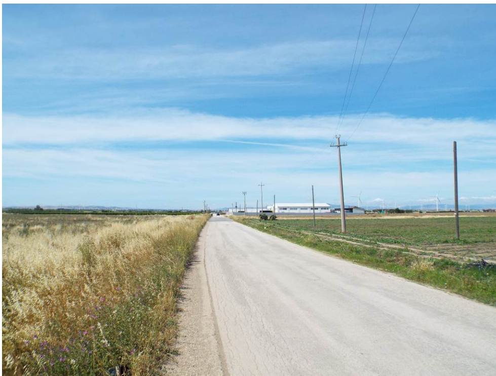
Foto P10.2: Vista della SP79 interessata dal passaggio del cavidotto interno dall'aerogeneratore WTG10 in direzione di Ortona
