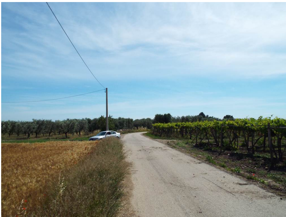
Foto P8.3: Vista della viabilità secondaria interessata dal passaggio del cavidotto interno verso l'aerogeneratore WTG09 dalla WTG08
