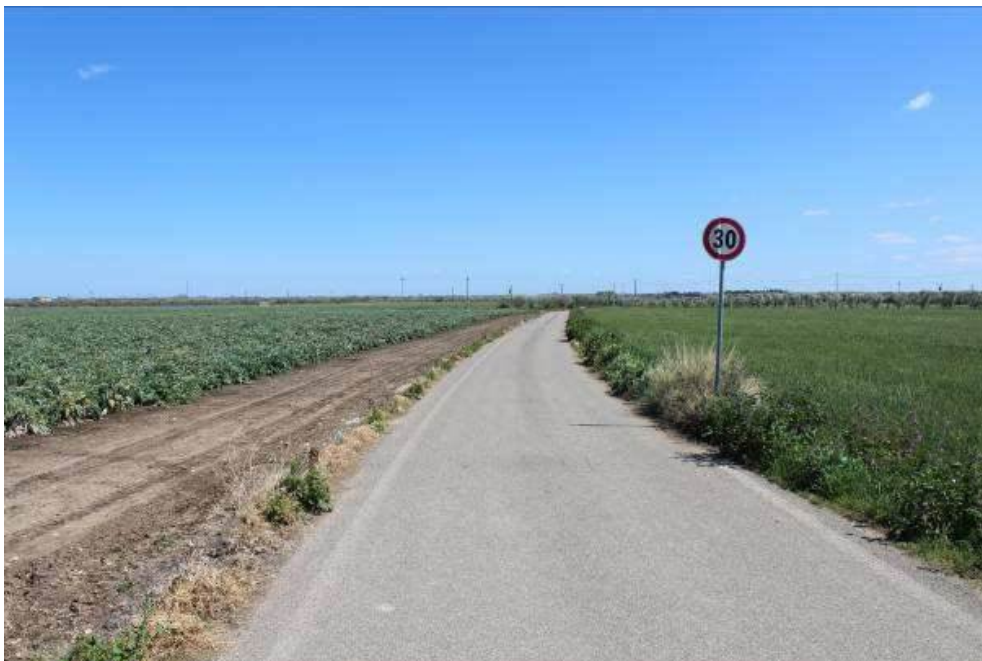
Foto P16.2: Vista dalla SP81 in direzione della SP83 interessata dal passaggio del cavidotto esterno. La SP81 coincide con il Trattarello Carapelle – Stornarella
