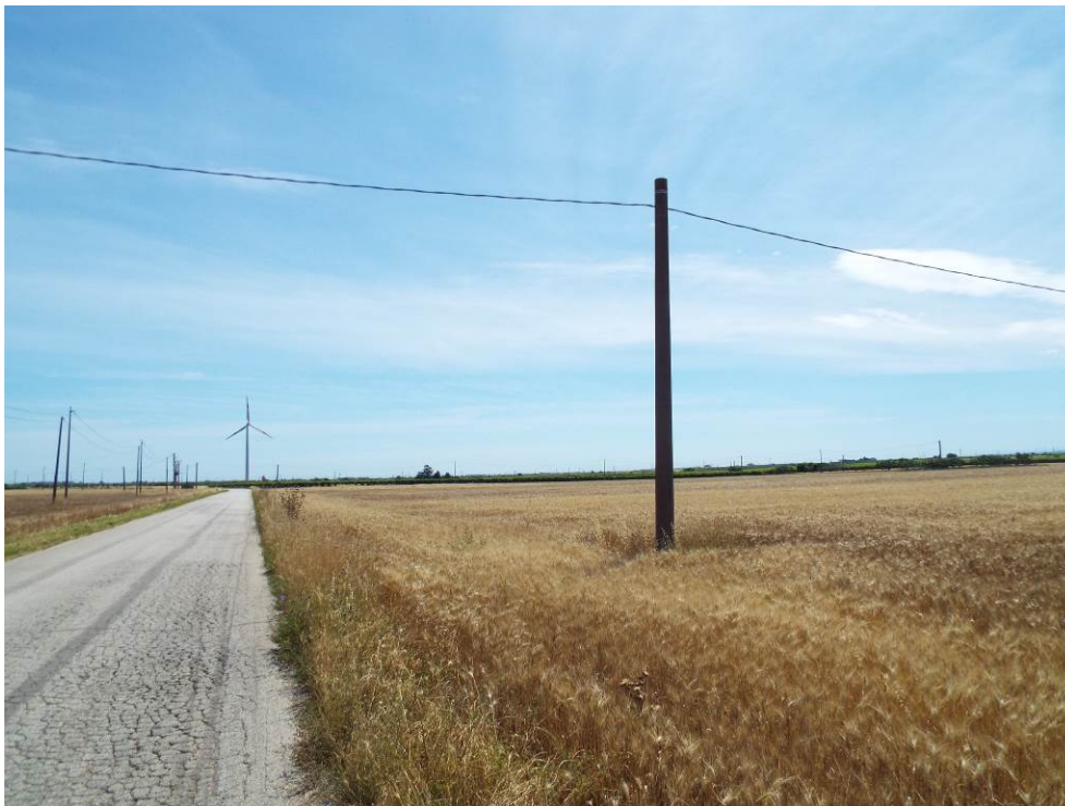
Foto P6.2: Vista dalla SP79, interessata dal passaggio del cavidotto interno in direzione dell'aerogeneratore WTG10, località Posta delle Canne – La Macina
