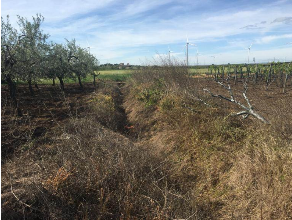
Foto P13.1: Vista del Canale Biasifficco – San Marchitto in prossimità dell’attraversamento del cavidotto esterno
