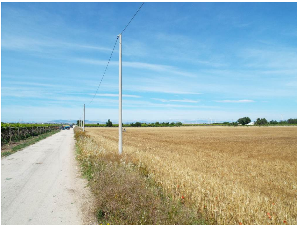
Foto P8.2: Vista della viabilità secondaria interessata dal passaggio del cavidotto interno verso l'aerogeneratore WTG07 dalla WTG08
