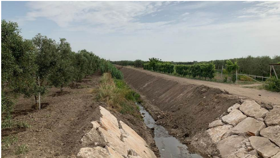
Marana La Pidocchiosa, in prossimità dell'attraverso del cavidotto esterno, in direzione nord
