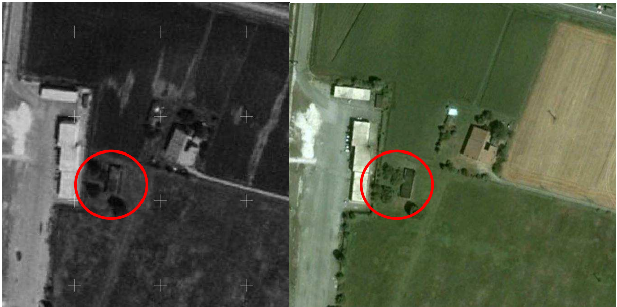
Fig. 8, 9- Dettaglio del podere Santa Marta negli scatti del 1994 e del 2003. Anche se poco le foto risultano poco nitide si può vedere l'edificio attualmente allo stato di rudere
