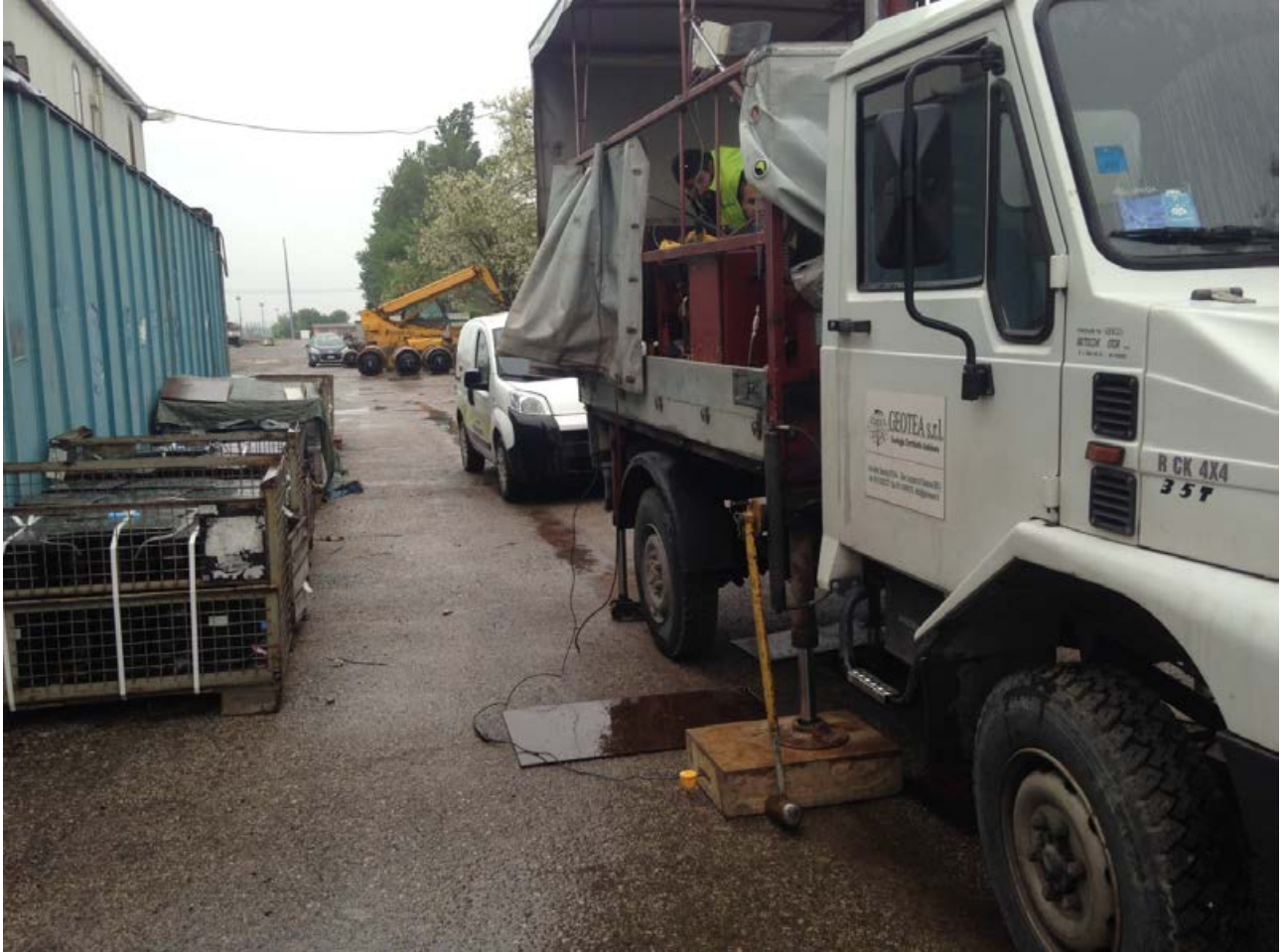
Figura 7 – Punto prova SCPTU eseguita con penetrometro 200 KN su Autocarro Bremach
