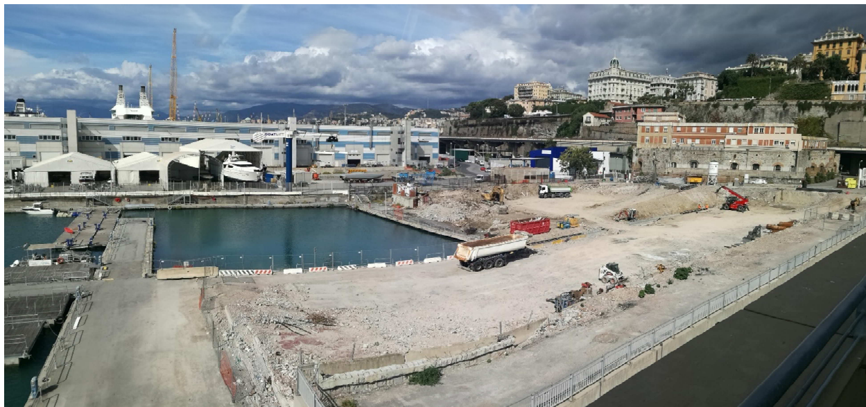
Figura 16. Foto del cantiere dell'imbocco canale
