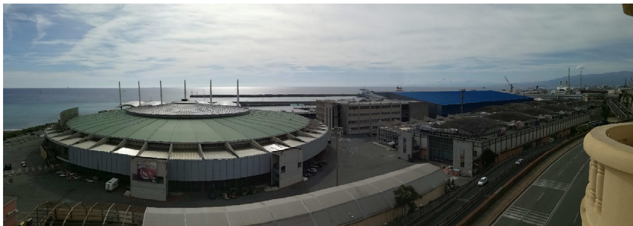
Figura 15. Foto dell'area dai palazzi di Corso Aurelio Saffi
