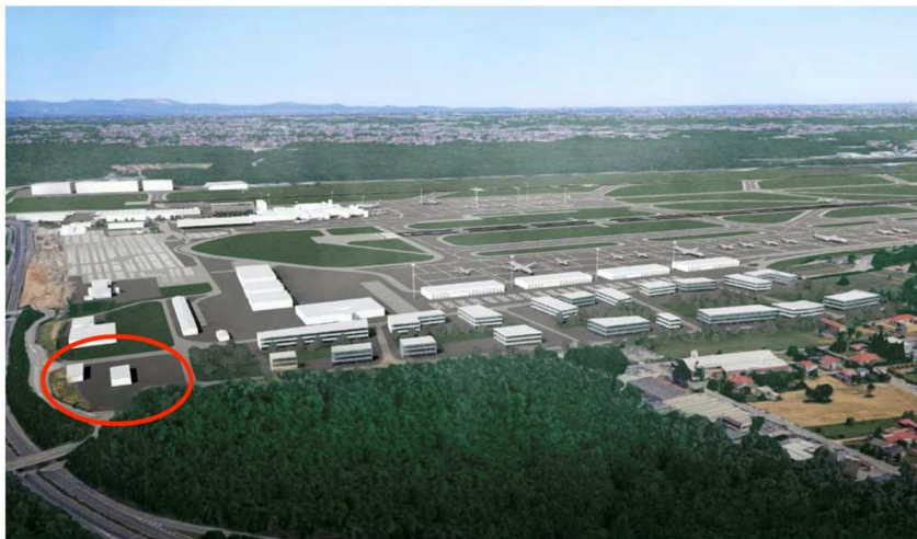
Figura 252 – Vista nuovi edifici di supporto e uffici area nord ovest
