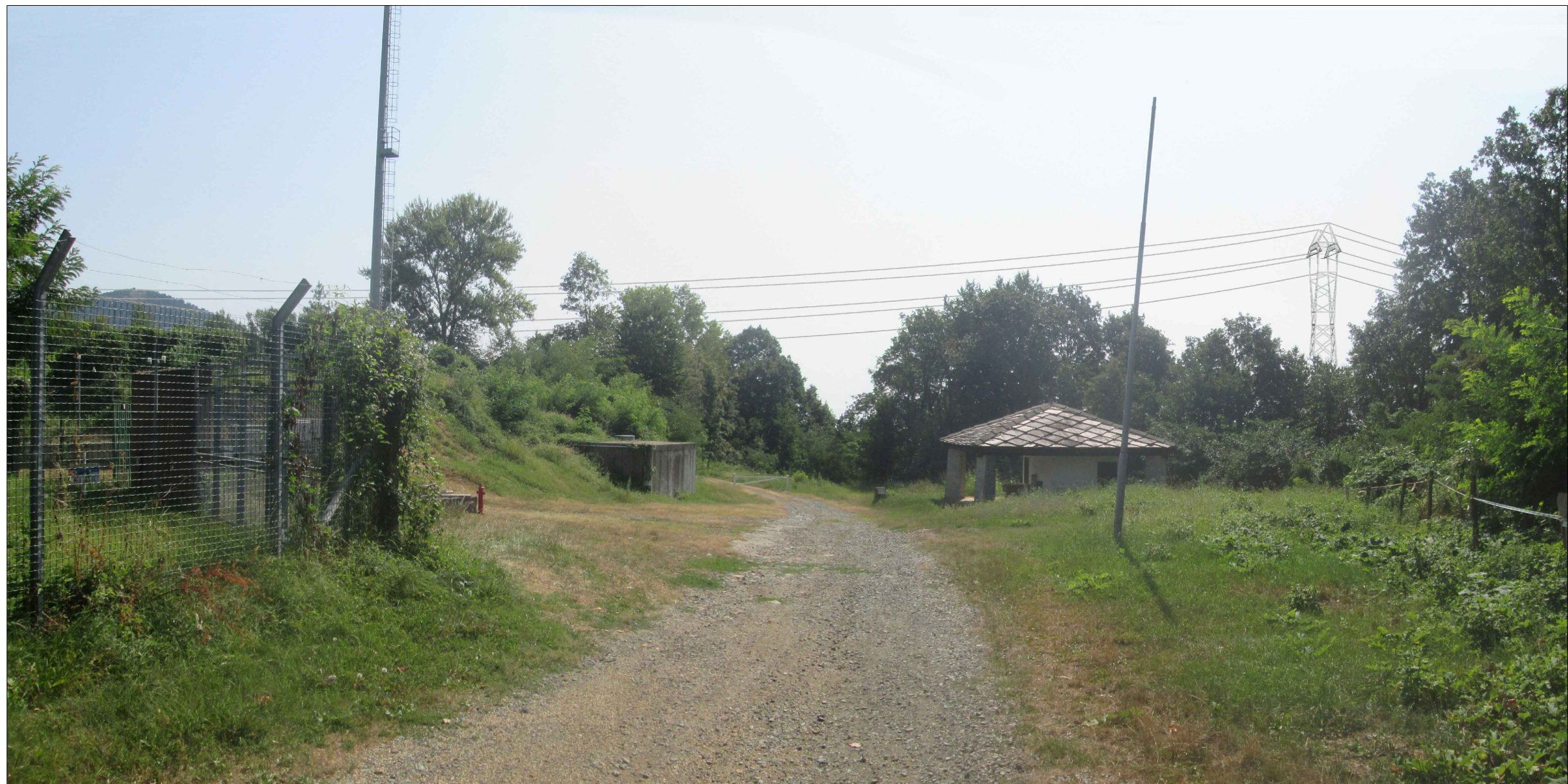
Fotoinserimento 7 - Vista dell'elettrodotto dai margini del Centro Sportivo Colombo (Comune di Balangero) in corrispondenza del sostegno 99
